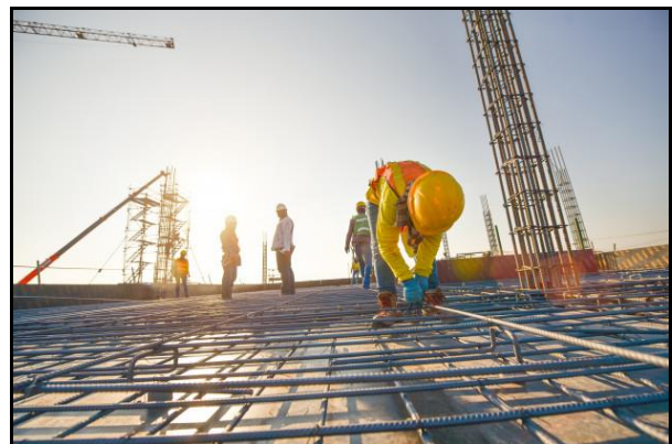
Trabajadores de la construcción, www.freepik.es
