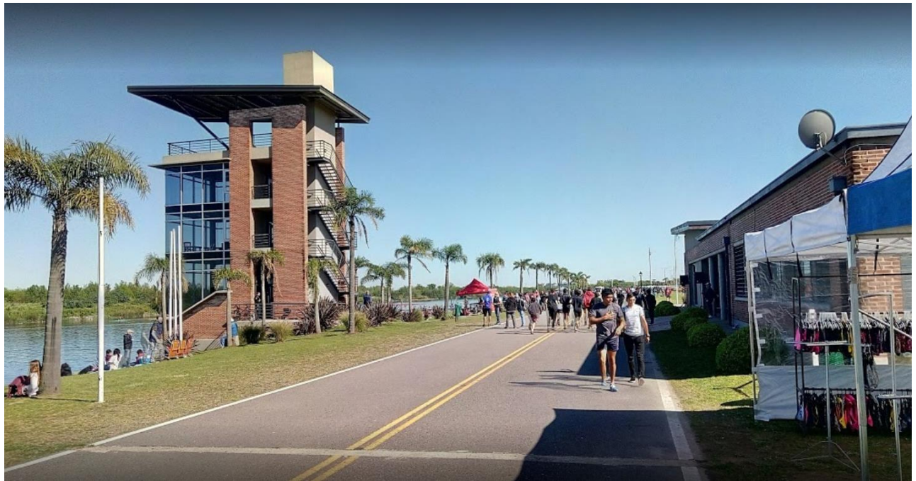
Caseta de jueces y corredor peatonal, pista de remo y canotaje, Buenos Aires, Argentina @ www.googlemaps.com
