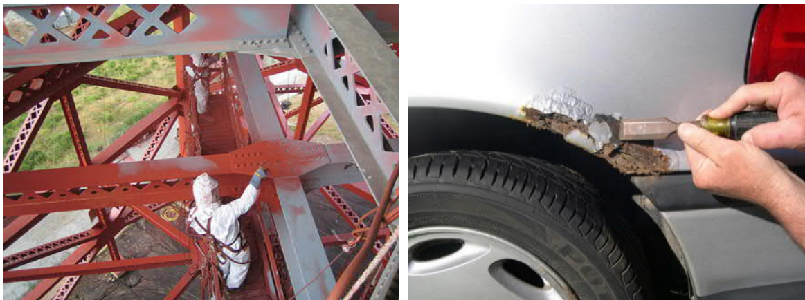
Figura 1. 1 Mantenimiento para evitar la corrosión
