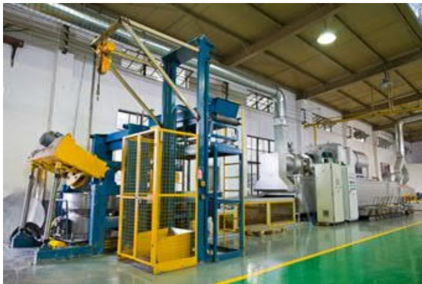
Figura 3. 8 Equipo para aplicación de pintura rica en cinc
