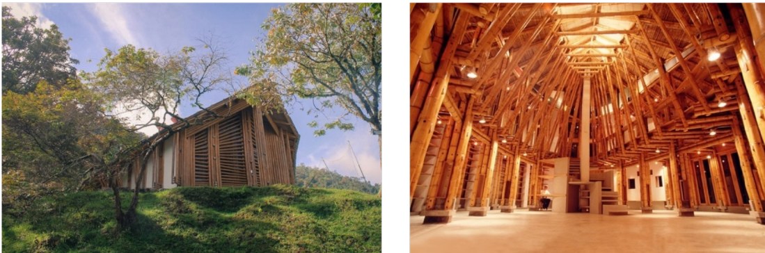
Ilustración 24. Biblioteca pública Casa del pueblo de Guanacas. (Izq. Fotografía del autor). Interior de la biblioteca, aún sin libros en 2003. (Izq. Fotografía de Simón Hosie)
