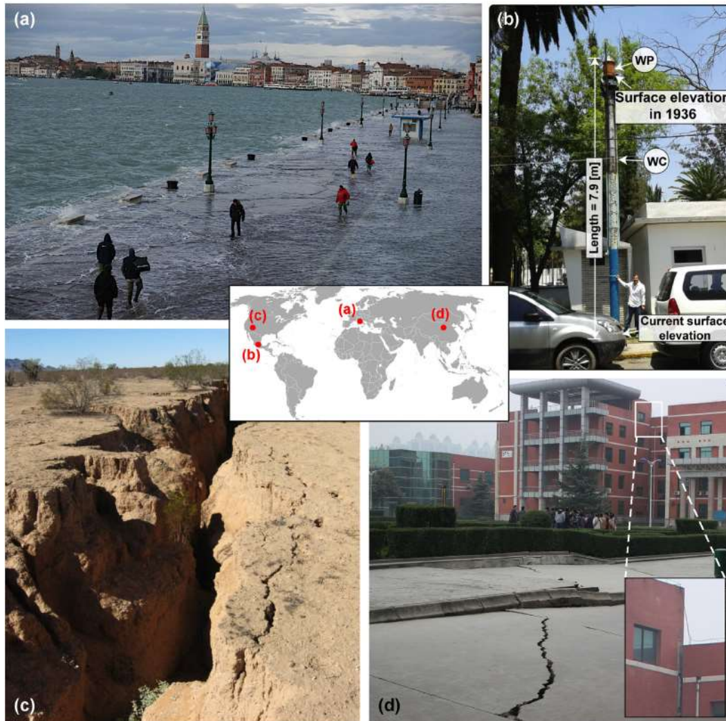
Figura 1. Consecuencias de subsidencia en el mundo. Tomada de Gambolati y Teatini, 2015. (a) Riva degli Schiavoni en Venice inundada durante marea alta registrada el 12 de February de 2013. (b) Protuberancia de un pozo localizado en la parte oeste de la Ciudad de México donde la subsidencia acumulada es de 8 m entre 1936 y 2013. WP: pozo de bombeo y WC: Cubierta del pozo (Hernández-Espriú et al. , 2014). (c) La fisura Rodgers de 13 m de profundidad ocurrió en Septiembre de 1997 en el Condado Maricopa, Arizona (Cortesía de Arizona Geological Survey, fotografía de Joe Cook tomada en Noviembre de 2008). (d) Grieta en calle y daños estructurales a edificios de Xian, China, alrededor de 2014 (cortesía de Shujun Ye, Nanjing University, China).
