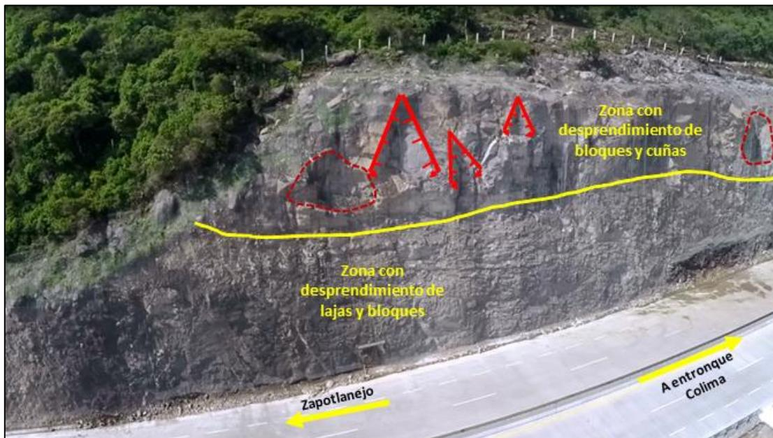
**Figura 1.5 En el tramo intermedio y final se observan varias cuñas de roca que se desprendieron del talud, principalmente en la parte superior debido al grado y características de fracturamiento.**
