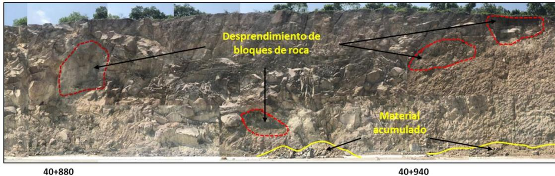
**Figura 1.4. Mosaico fotográfico del talud, donde muestran desprendimientos de bloques de roca.**
