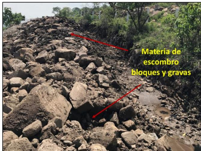
Figura 4.14 Acercamiento al material de escombros en la porción superior del talud.
