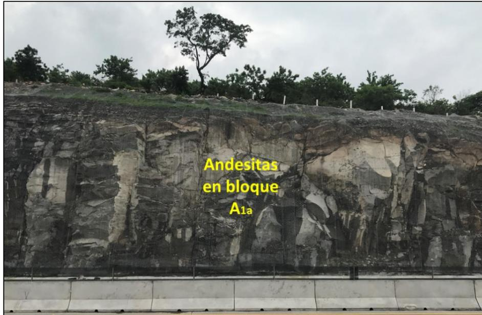
*Figura 4.12 Andesita en bloques (A<sub>1a</sub>), con amplio espaciamiento de sus fracturas, que delimitan bloques grandes.*
