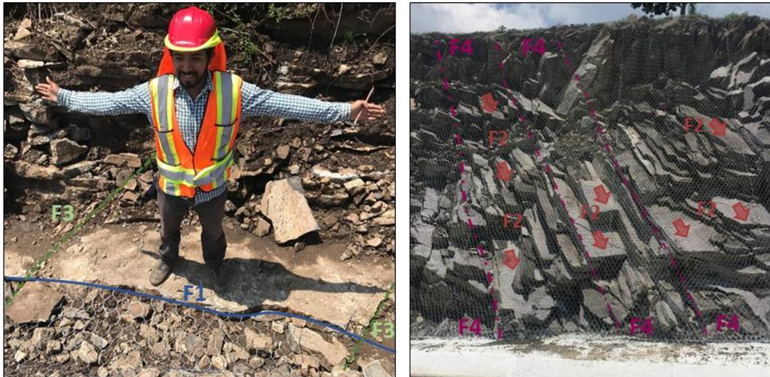
Figura 4.17 Familias de fracturamiento en la porción alta y baja del talud (F1, F2, F3 y F4)
