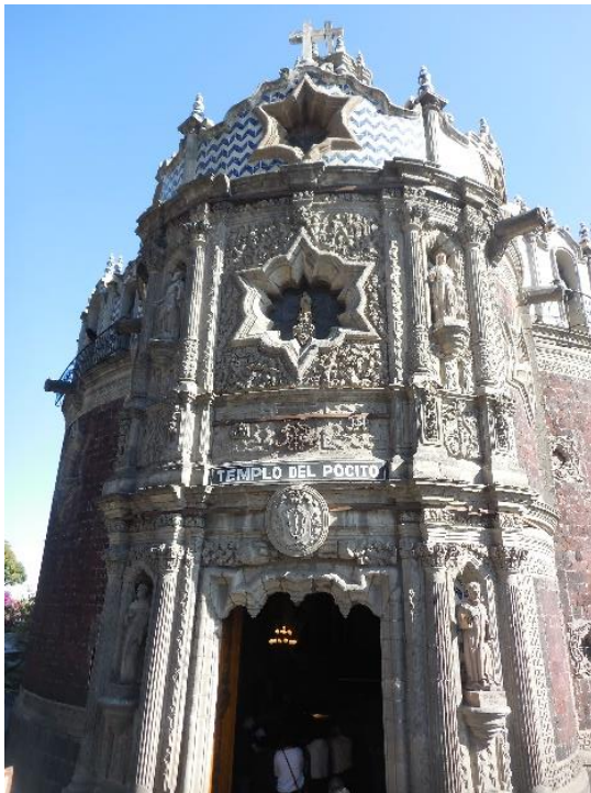
Figura 27. Fotografía de la Iglesia del Pocito. Autoría propia.
