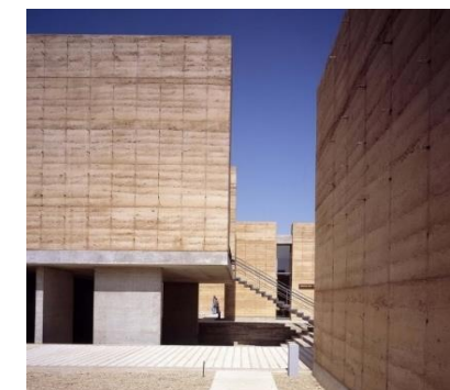
Figura 106. Escuela de Artes Visuales. Mauricio Rocha. Fuente: ArchDaily, 2011.
