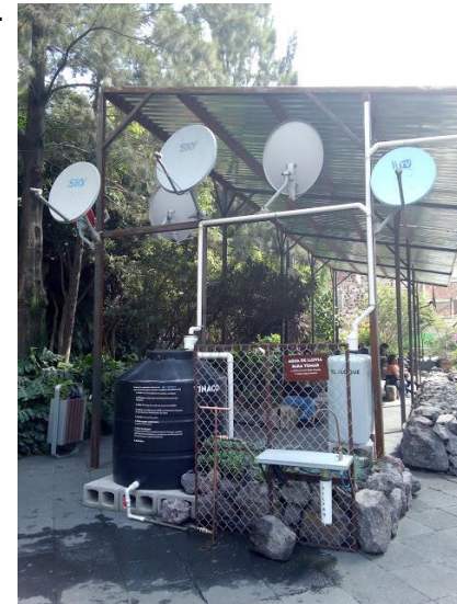
Figura 96. Muestra del Sistema de Captación Residencial ( Isla Urbana . Exposición en el Atrio de San Francisco, 2018).
