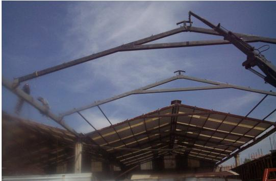
1.- Se colocaron en la parte superior de las columnas los montenes empatados de 12" y formas o brazos principales los cuales fueron soldados y acoplados con tornillos de alta resistencia para evitar fragmentaciones por una mala soldadura, todo ello para soportar el armado y el peso de la lámina.
