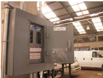
Fig 10. TABLERO DE DISTRIBUCIÓN PARA ALUMBRADO MARCA SQUARE D .Modelo NQOD124L12 CLASE 1630
