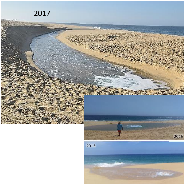
Figura 83. Zona de desagüe de agua residual en la planta Desaladora, la cual presenta cambios en la acumulación de sedimento entre los años 2015 al 2017.
