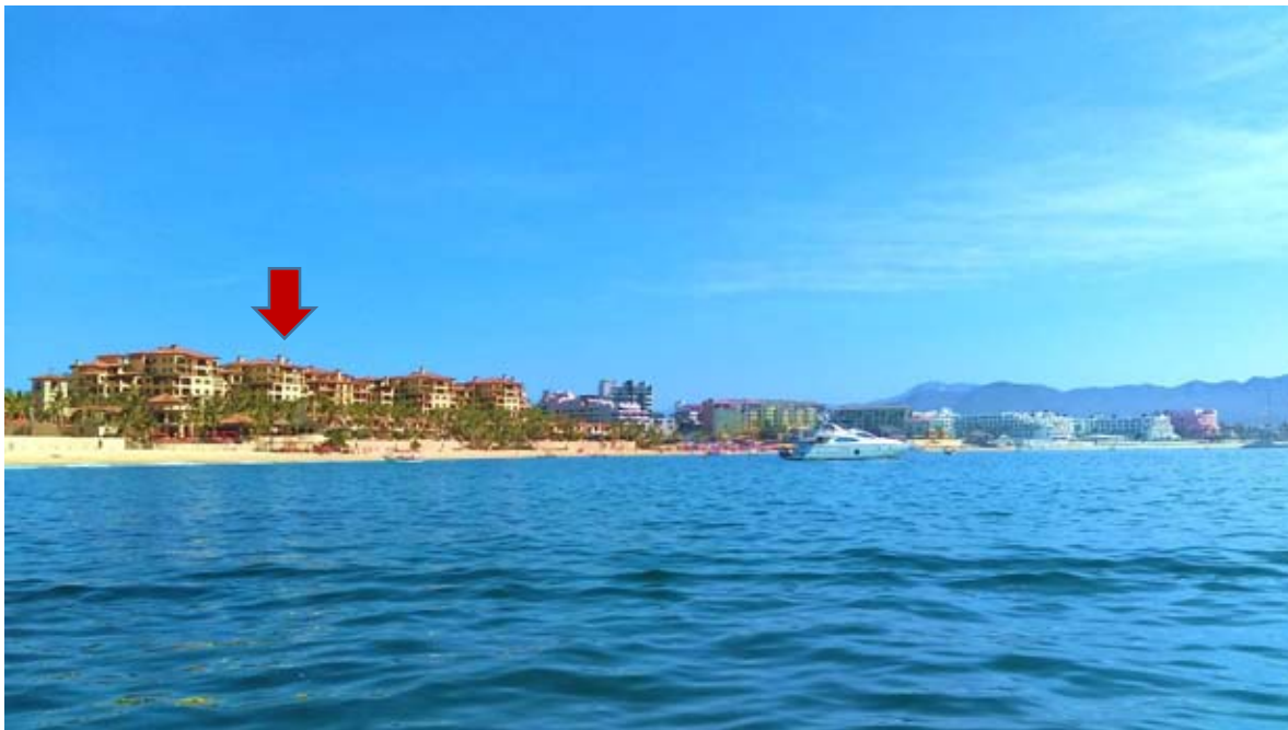
Figura 44. Vista panorámica de la zona hotelera de la Bahía de CSL, se resalta la presencia del H. Hacienda Beach (flecha roja). La playa es de uso público local con secciones de playa privada, principalmente a un costado de la estructura hotelera.
