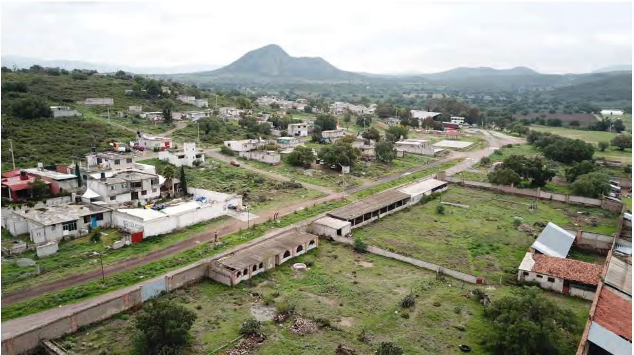
71. Entorno edificado y natural de la hacienda vista panorámica. Fotografía del autor, 2019.
