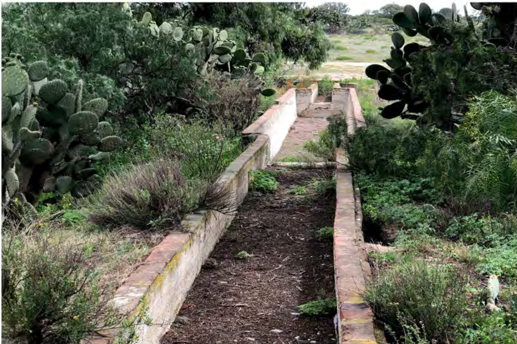
49. Elemento hidráulico canal conductor al filtro ubicado en planicie recorre cuatro kilómetros del jagüey encontrados entre el cerro del Chilete hasta el jagüey de la hacienda. Fotografía del autor, 2018.
