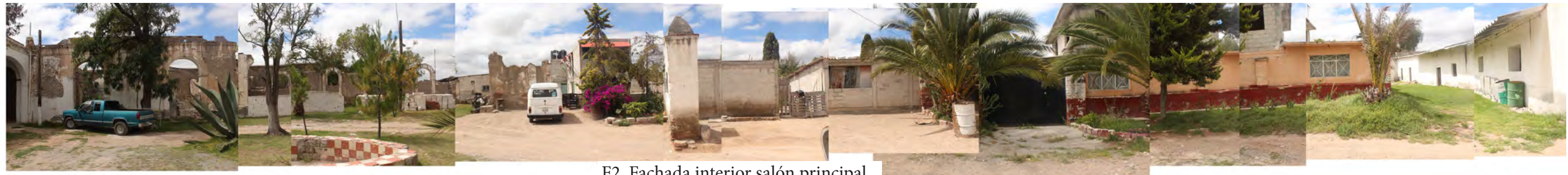
F2. Fachada interior salón principal
