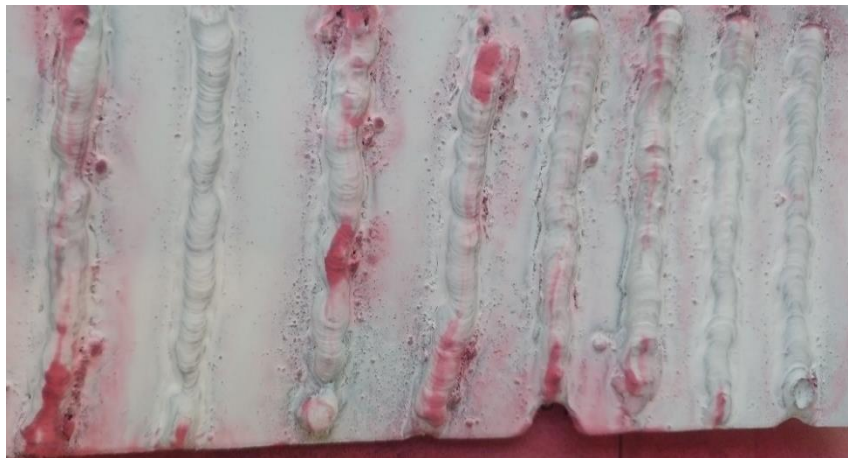
Figura 26. Inspección de cordones con electrodo E-6013.
