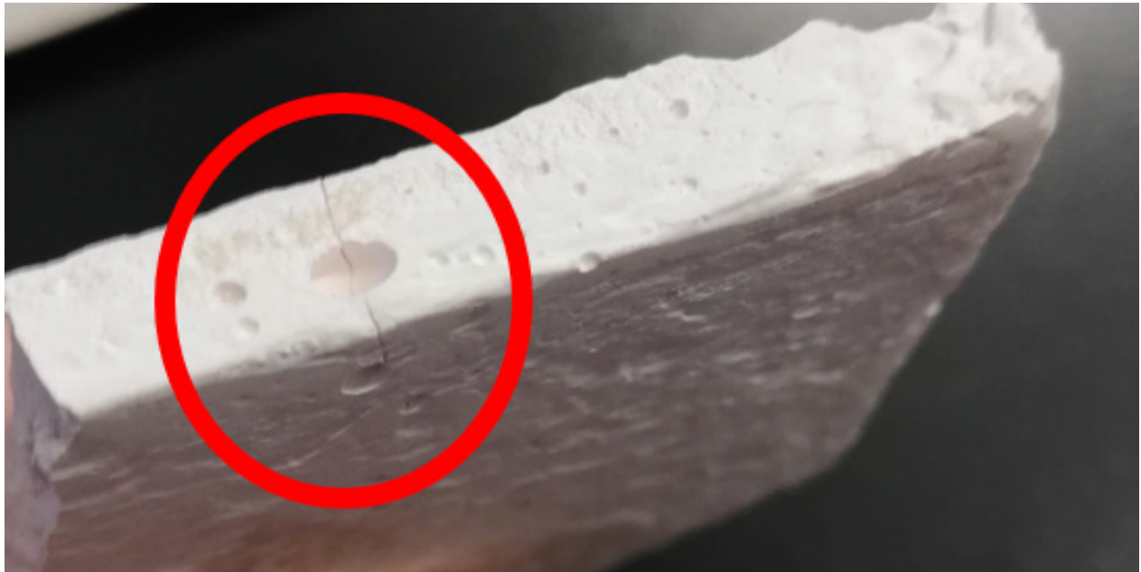
Figura 9. Propagación de grietas a través de burbujas de aire en el ensayo de intemperismo acelerado
