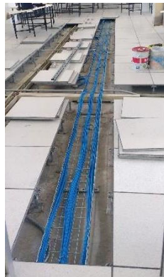
Figura 1-10 Instalación de cable Cat 6A (propia)
