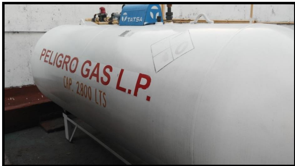
Imagen 3: Tanque de gas natural
