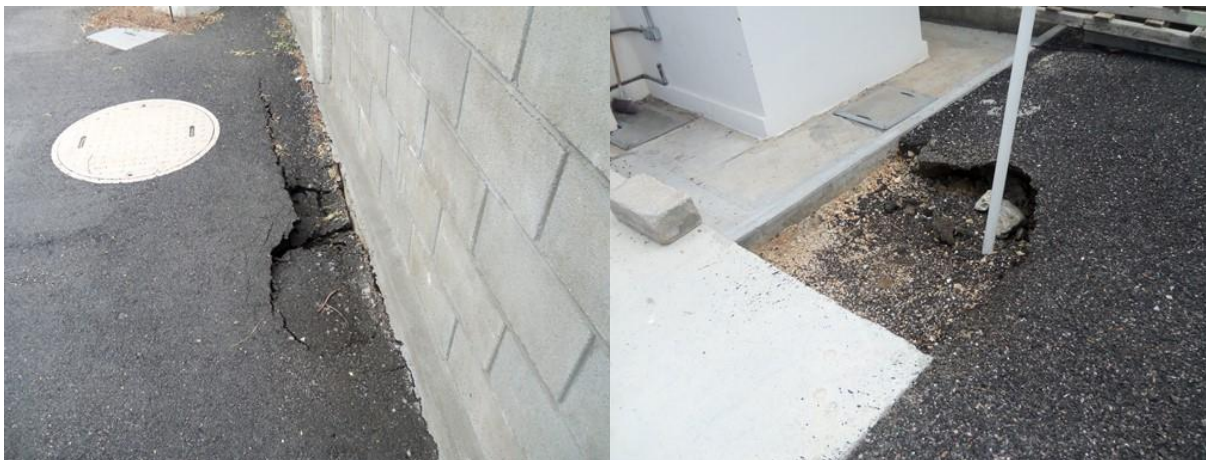
(11).- Subestación Cabo Falso – (CAF):
