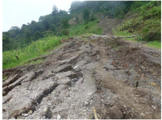
Destrucción total de camino.
