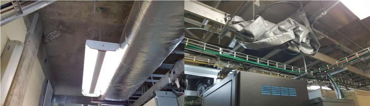
(6).- Subestación Cabo Real – (CRE):
