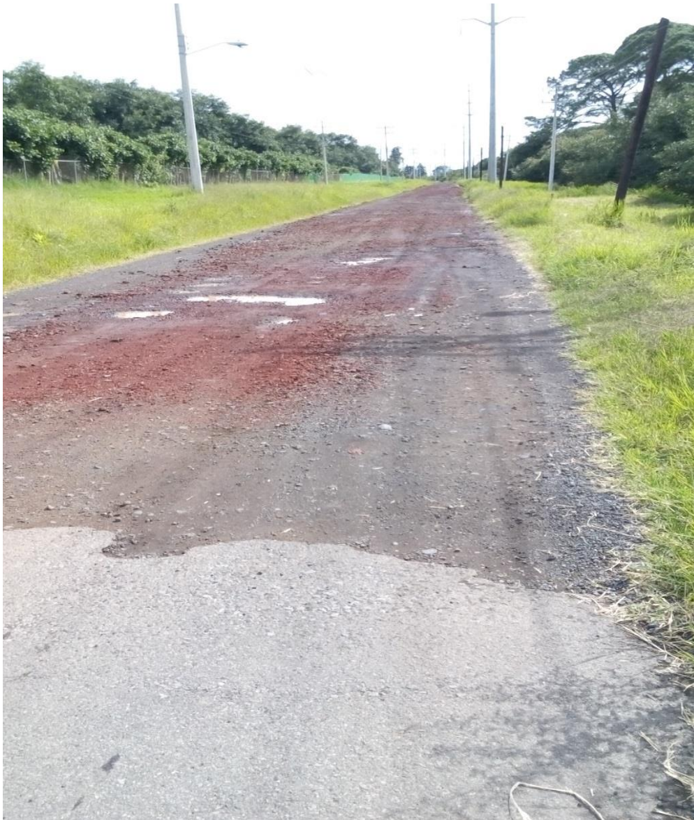
Imagen 3.8.- Terminacion de la carpeta asfaltica, comienzo de terraceria.
