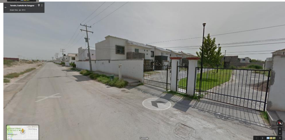
Imagen 17 Colindancia al Oriente del predio. Fuente: Google Earth.
