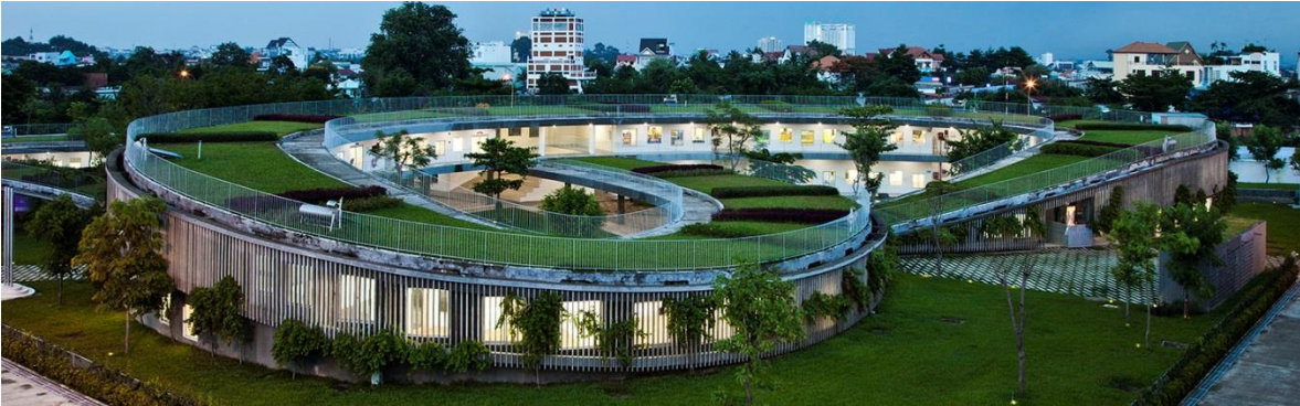
Gráfico 4. Perspectiva del Proyecto de Jardín Infantil Farming / Vo Trong Nghia Architects, Archdaily.
