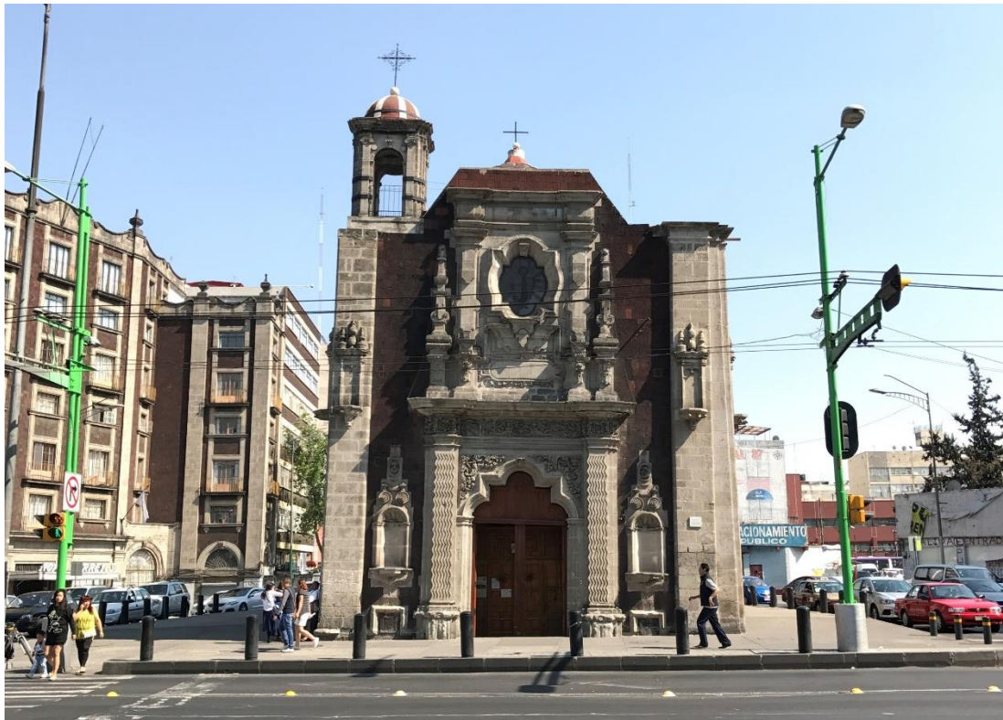
Templo de la Purísima Concepción de salto del agua, vista sobre eje central Lázaro Cárdenas.
