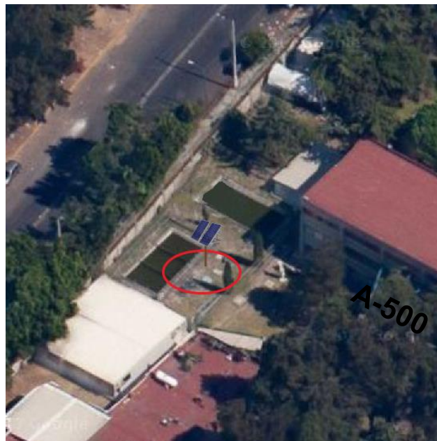
Imagen 18. Ubicación para instalación de módulos fotovoltaicos
