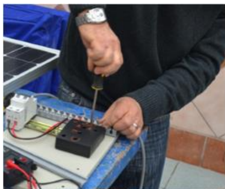
Imagen 8. Instalación de regulador de carga
