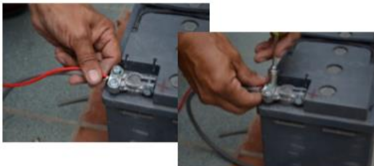
Imagen 10. Colocación de conductores eléctricos
