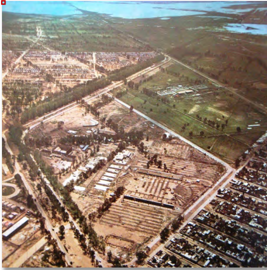
Imagen 9 Construcción del Deportivo Oceanía, 1963. Fuente: Repositorio de Imágenes Históricas de la CDMX.9
