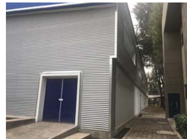
Imagen 232. Fachada Poniente y Sur, conformada por un pasillo de paso con una salida de emergencia del auditorio.
