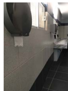
Imagen 257. Papel de baño dispuesto a una mayor altura de la requerida.
