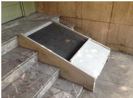
Imagen 4. Rampa diseñada por los usuarios para la entrada de su edificio, esta se puede expandir cuando se necesita, sin embargo, puede generar accidentes, no es parte del contexto y no cuenta con la pendiente adecuada. Funciona para el fin básico solamente.
