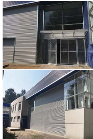
Imagen 225 y 226. Fachada Oriente del edificio, se aprecia la entrada principal y dos puertas que sirven de salida de emergencia y cumplen una función administrativa.
