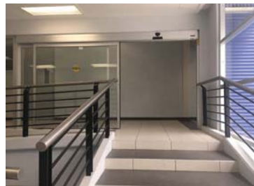
Imagen 234. Rampa ubicada en la planta alta que da acceso a un laboratorio y a la terraza. La puerta de acceso cuenta con sensor de movimiento y apertura automática.
