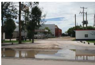
Imagen 27. Paso obstruido por las inundaciones.
