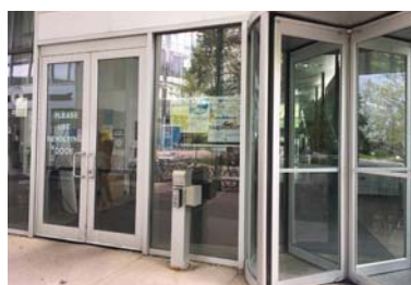
Imagen 102. Combinación de puertas circulares, de empuje y con control de apertura. Universidad de Toronto, Mississauga, Canadá
