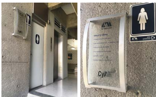
Imagen 91. Señalización que no se ve ni se puede leer fácilmente, carece de simbología Braille y contraste, está demasiado alta. UAM Xochimilco
