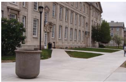
Imagen 32. Rampa integrada desde la ruta de acceso hasta la puerta. Universidad de Búfalo, NY, Campus Sur.
