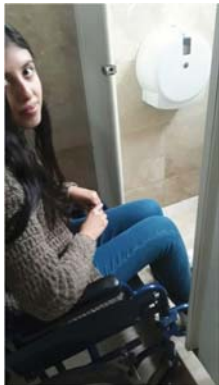
Imagen 48. Las puertas angostas en los baños no permiten el uso por personas en silla de ruedas. Foto. Nicoelle Alvarez, Universidad Tadeo Lozano, Bogotá, Colombia.
