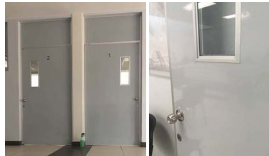
Imagen 244. Puertas de las aulas, al estar abiertas tienen una anchura de 90 cm. Imagen 245. Manija de bola y ventanilla.
