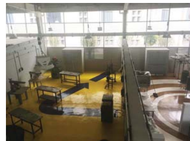
Imagen 231. Salidas de emergencia fachada norte vistas desde el interior de los talleres.
