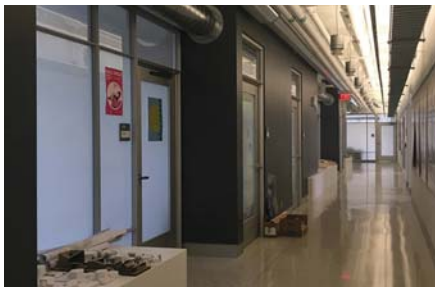
Imagen 82. El uso de ventanales opacos permite la percepción de que hay movimiento dentro o fuera del aula pero reduce las distracciones, no aísla el ruido de una manera adecuada. Universidad de Buffalo, NY, EUA.
