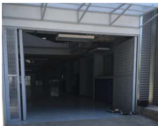
Imagen 229. Puerta general abierta de par en par.
