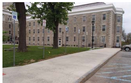
Imagen 60. Los espacios para PCD se encuentran cerca del edificio, marcados y con las dimensiones necesarias para su uso adecuado. Universidad de Buffalo, NY, EUA.
