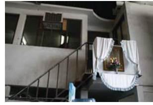
Imagen 34. Acceso a oficinas.
