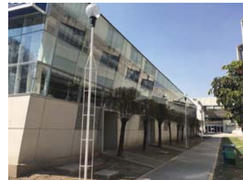
Imagen 230. Fachada Norte donde se pueden ver las cuatro puertas de emergencia que salen de cada taller.
