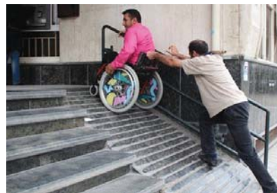
Imagen 3. Una rampa mal diseñada puede crear mas riesgos que beneficios. http://chef.bbci.co.uk/news/624/cpsprodpb/10C91/production/_85235786_ramp.jpg
