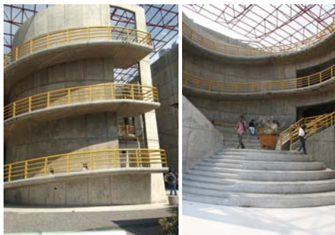
Imagen 70 y 71. La integración de las rampas y escaleras aprovechando el diseño arquitectónico presenta una propuesta estética pero no totalmente funcional ya que los tramos son muy largos y no cuentan con descansos. UAM - Xochimilco
