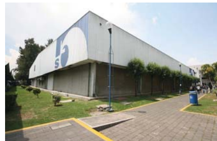
Imagen 174. Taller de Diseño Industrial, edificio original.
