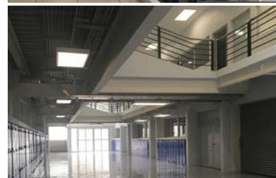
Imagen 267. Iluminación general en el pasillo de la planta alta y planta baja.
