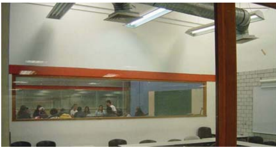
Imagen 204. Salones con un vidrio de separación que genera distracción en las dos aulas, las condiciones del techo hacen que la temperatura sea excesiva y los sistemas de ventilación son demasiado ruidosos y no han tenido mantenimiento por lo que es imposible utilizarlos en clase.
