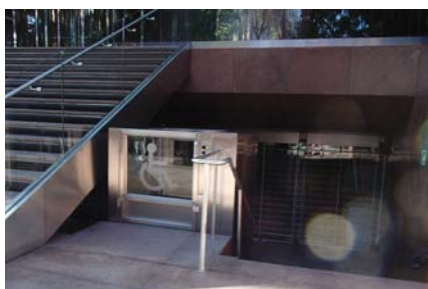
Imagen 25. Elevador integrado en el diseño del espacio el cual no interfiere con el diseño estético del edificio.
