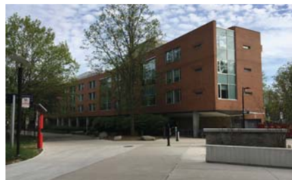
Imagen 67. Integrar los principios de Diseño Universal desde un principio genera espacios inclusivos y adecuados para las necesidades de los usuarios. Área de entrada con rampa integrada, espacios para sentarse, señalética y elementos de seguridad. Universidad de Toronto, Mississauga, Canadá
