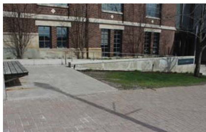
Imagen 27. Rampa de ingreso integrada a la fachada del McLaren Art Center, Barrie ON, donde al mismo tiempo aprovechan la pendiente de la calle.
