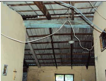
Cumbrera entre el pasillo y el portal de CT-5A
