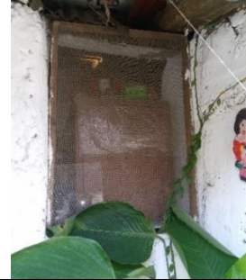
Ventana norte del portal. Vista exterior
