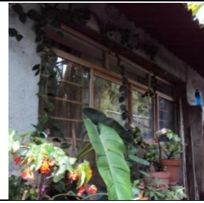
Ventana oriente del portal. Vista exterior
