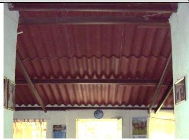
Cumbrera entre el pasillo y el portal de CT-5B
