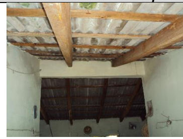
Cumbrera entre el pasillo y el portal de CT-5C
