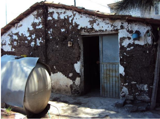
Muro de adobe repellado con enjarre y pintura a la cal. Caso CT-2A
