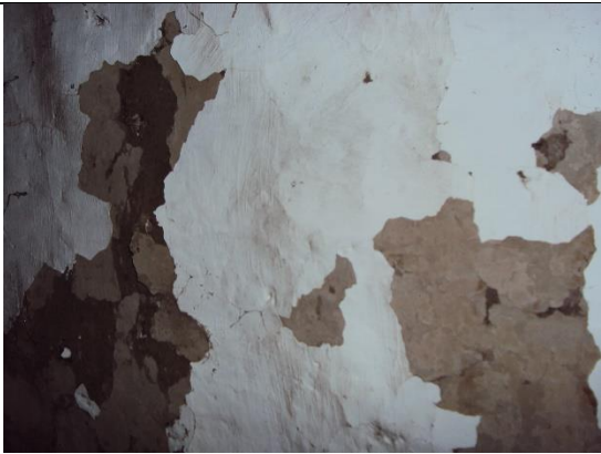
Detalle de repellado con enjarre y pintura a la cal. Caso CT-1A.
