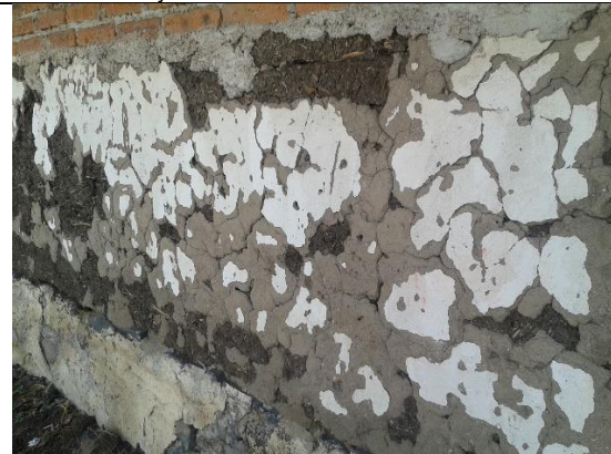
Detalle de repellado con mortero a base de arena y cemento y pintura a la cal, carece de malla exagonal. Casa tradicional en MV.
