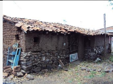
Fachadas, oriente (der.), sur (izq.)
