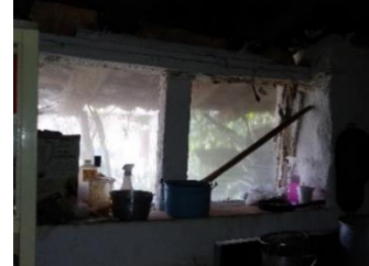
Ventana sur del portal. Vista interior
