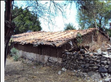
Fachadas, sur (der.), poniente (izq.)
