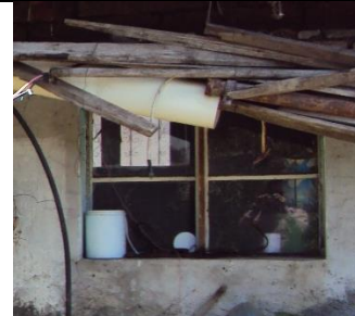
Ventana oriente del portal. Vista exterior
