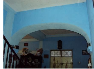
Detalle de arco carpanel de tres centros
