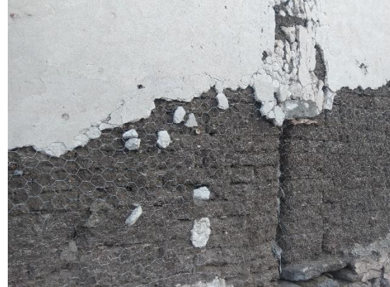
Muro de adobe con malla exagonal y repellado con mortero de arena fina y cemento. Casa tradicional en MV
