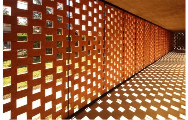
El encargo consta de la construcción de cuatro habitaciones de fin de semana, materializadas mediante planos horizontales y verticales de hormigón armado que determinan su estructura portante y espacial. El cerramiento exterior del pabellón está constituido por paneles autoportantes de ladrillo de construcción en seco.
