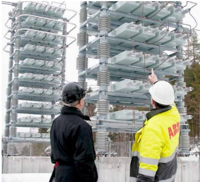
Figura 2.16. Banco de capacitores de 300 Mvar/420 kV/50 Hz, en Noruega – Imagen recuperada de [Catálogo ABB - Power Capacitors and Harmonic Filters · 2013, p. 6].
