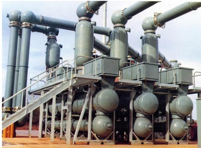
*La primera GIS de 800 kV de envolvente metálica. Instalada en Joshua Falls, EE. UU, 1980 - Imagen recuperada de [THINK GRID N°10 – Verano de 2012, p. 48].*
