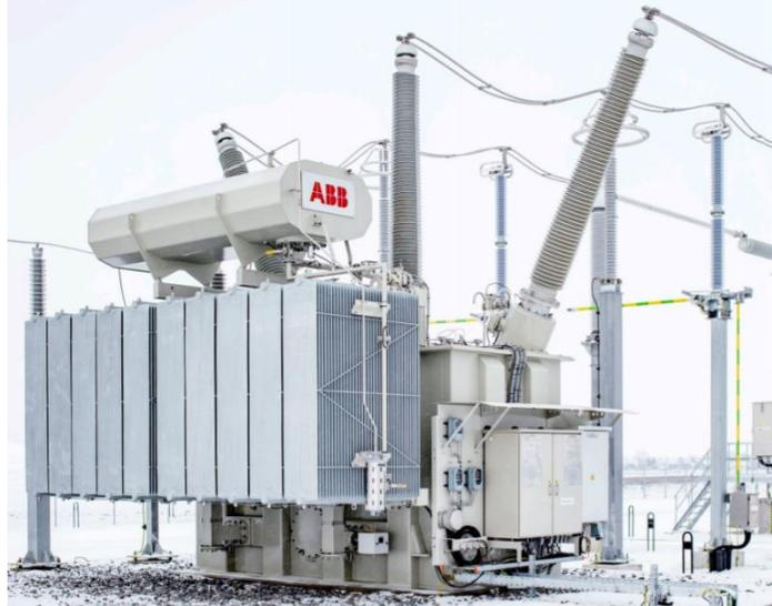
*Figura 2.20. Reactor shunt– Imagen recuperada de [Catálogo ABB - Shunt reactors · 2018, p. 2]*
