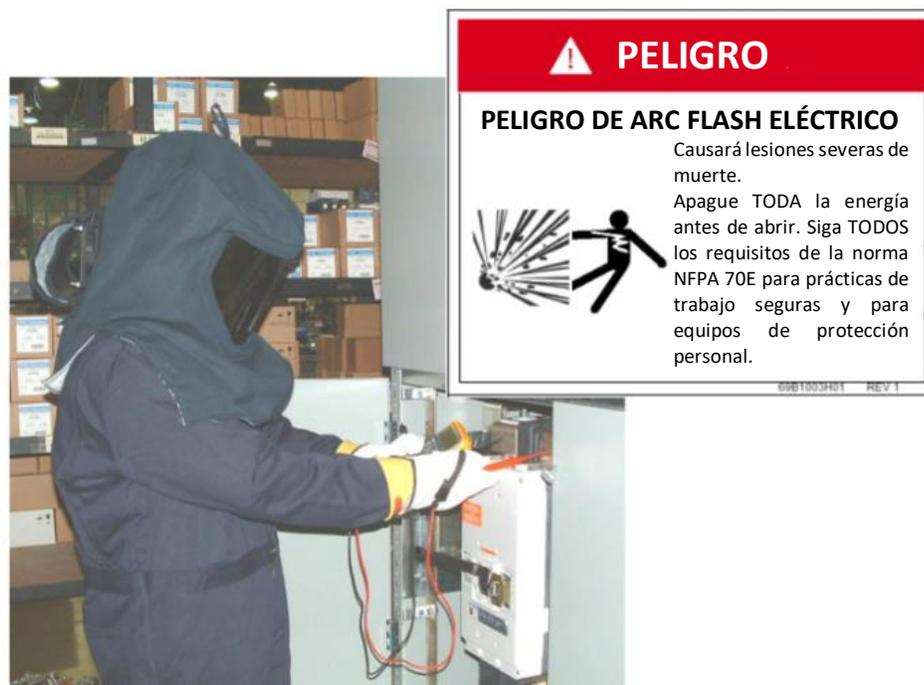
Figura 5.7. Ejemplo de equipo de protección personal (PPE) para proteger contra los efectos del arco eléctrico, como lo exige la NFPA<sup>121</sup> 70E – Imagen recuperada (traducida) de [Schoten, P., Dingle, P. y Kaminskyj, W. (2007), p. 2].
