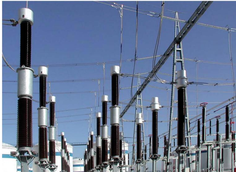
Figura 2.9. Transformadores de instrumento - Imagen recuperada de [Catálogo Artech - Transformadores de tensión inductivos, p. 23].
