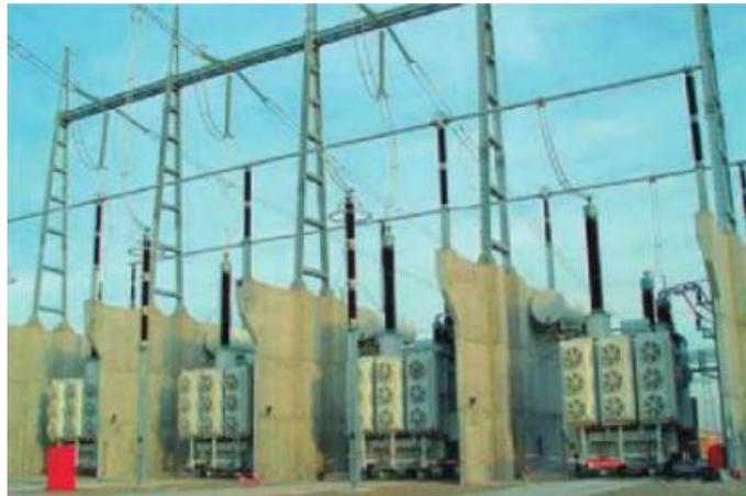
Figura 2.6. Banco trifásico (3 monofásicos + 1 de reserva). Fuente: ABB - Imagen recuperada de [Trashorras Montecelos, J., p. 78].
