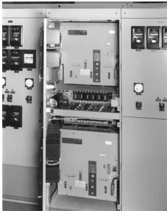
*Figura 5.6. Dos unidades metal-clad switchgear con una potencia nominal de 13.8 kV y 2 000 A, con interruptores automáticos de vacío. (Foto cortesía de Powell Industries, Houston, Texas) – Imagen recuperada de [Bridger, B. y Brusso, B. (2014), p. 9].*
