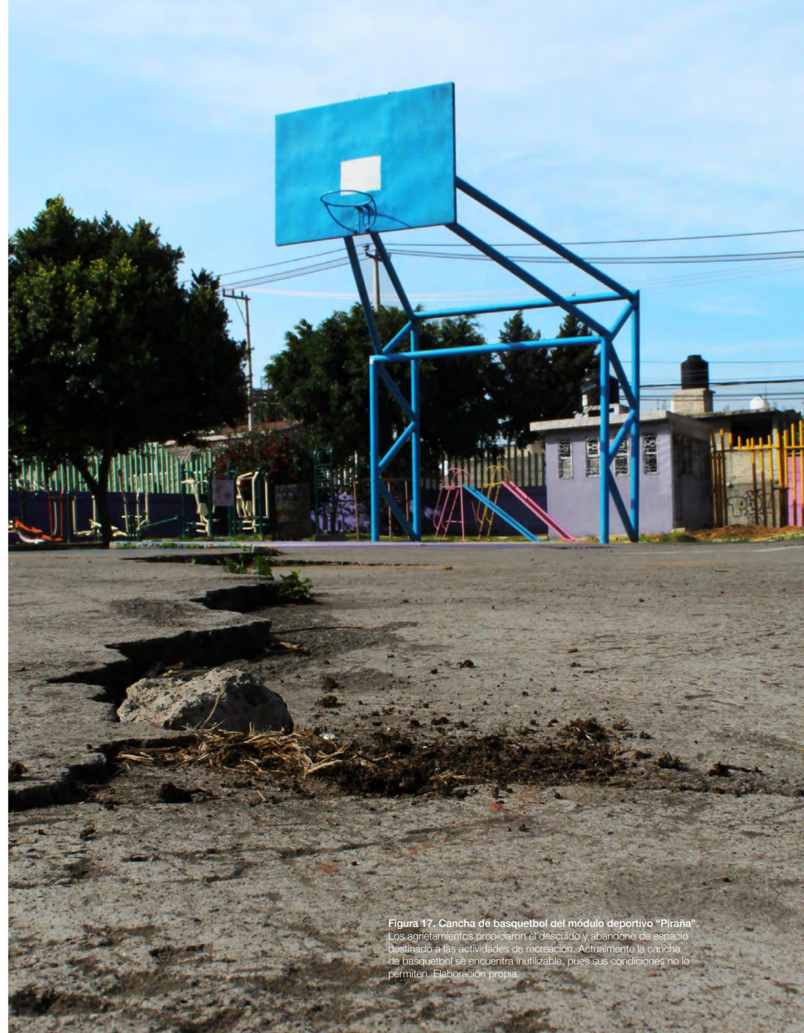
**Figura 17. Cancha de basquetbol del módulo deportivo "Piraña".** Los agrietamientos propiciaron el descuido y abandono de espacio destinado a las actividades de recreación. Actualmente la cancha de basquetbol se encuentra inutilizable, pues sus condiciones no lo permiten. Elaboración propia.
