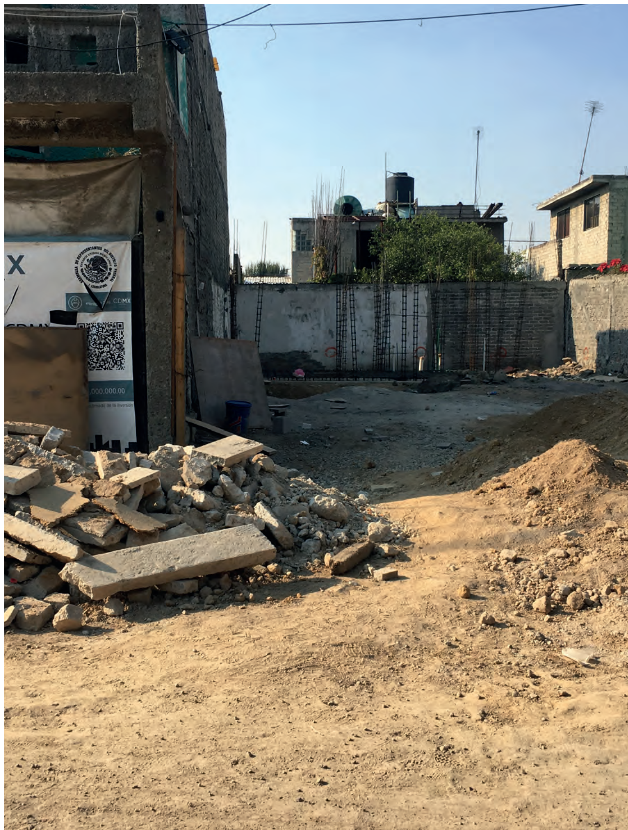
Fig 18. Vivienda con afectación grave
