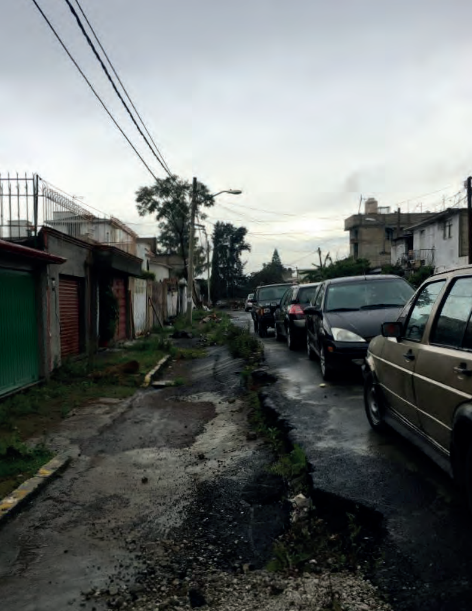
Fig. 1 Agrietamiento en calle Gitana
