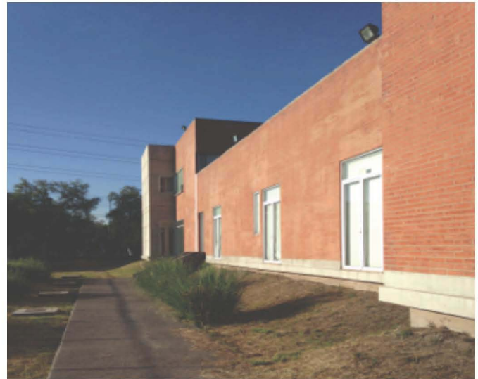
Fachada Oriente, acabados de tabique rojo. Fuente: Autoría propia.
