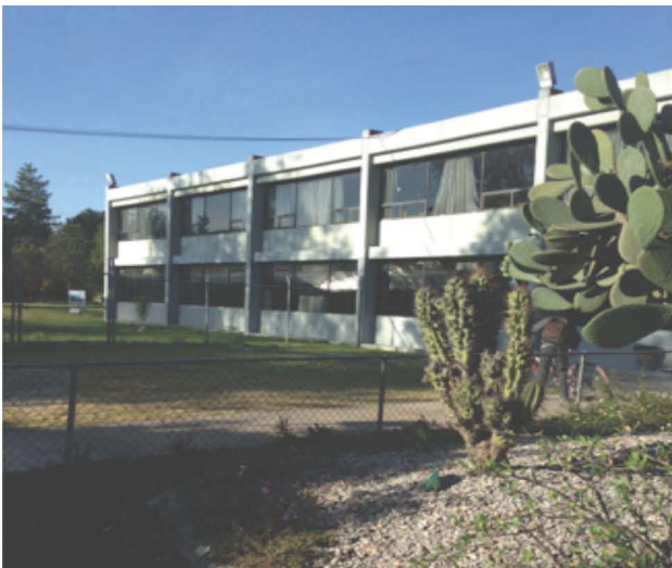
Fachada Poniente. Fuente: Autoría propia.
