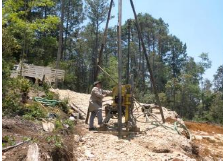
Realización de prueba de penetración estándar, norma: ASTM-D-1586-2008
