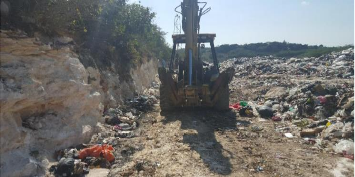
Ejecución de sondeo, pozo a cielo abierto (PCA), en el municipio Comitán de Domínguez, Chiapas con máquina retro excavadora. norma: NMX-C-430-ONNCCE-2002.
