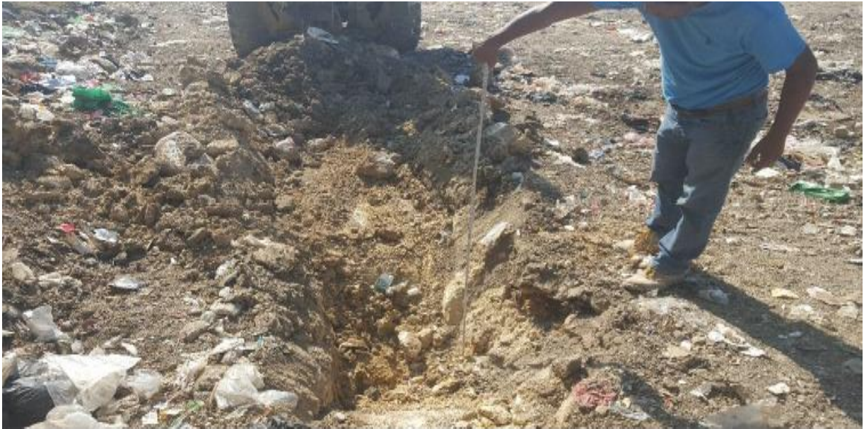
Ejecución de sondeo, pozo a cielo abierto (PCA), en el municipio Comitán de Domínguez, Chiapas con máquina retro excavadora. norma: NMX-C-430-ONNCCE-2002.
