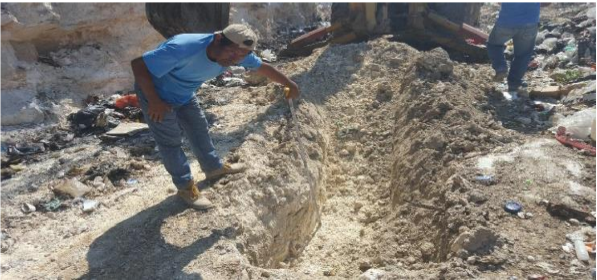
Ejecución de sondeo, pozo a cielo abierto (PCA), en el municipio Comitán de Domínguez, Chiapas con máquina retro excavadora. norma: NMX-C-430-ONNCCE-2002.
