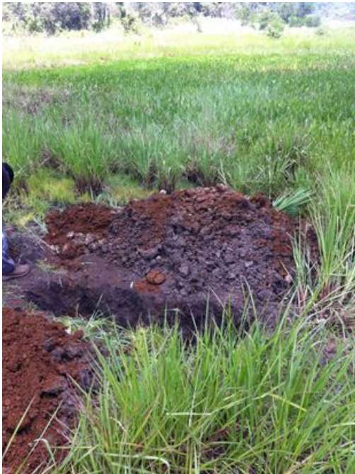
Ejecución del pozo a cielo abierto con herramienta menor.
