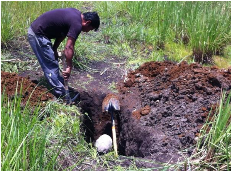
Ejecución del pozo a cielo abierto con herramienta menor.
