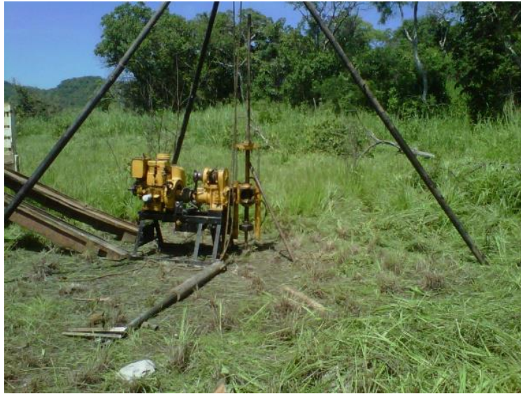
Sondeo profundo tipo mixto SPM-1, Maniobra y colocación de máquina perforadora.
