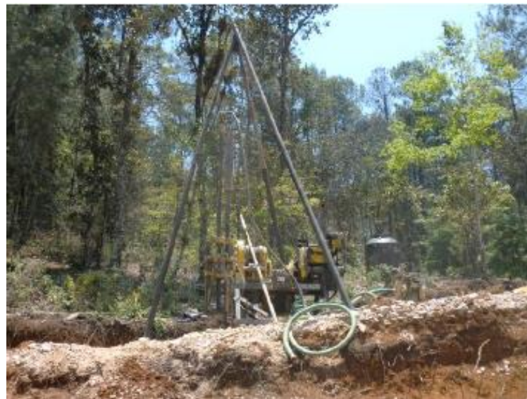
Realización de prueba de penetración estándar, norma: ASTM-D-1586-2008
