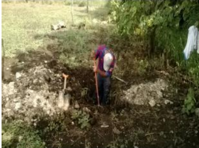
Ejecución de la prueba de pozo a cielo abierto con herramienta menor.
