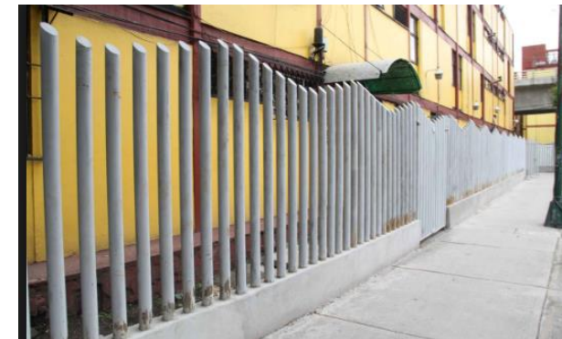
Imagen 36: Barda perimetral de concreto con perfiles tubulares
