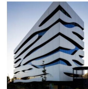
Imagen 65: Utilización de panel Trespa Meteon
