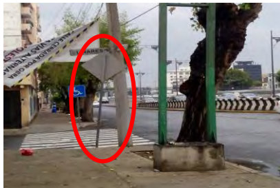
Imagen 1.3.21: Viaducto. Miguel Alemán
