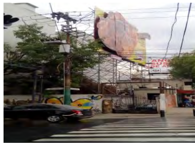
Imagen 1.3.17: Viaducto Miguel Alemán y Monterrey.
