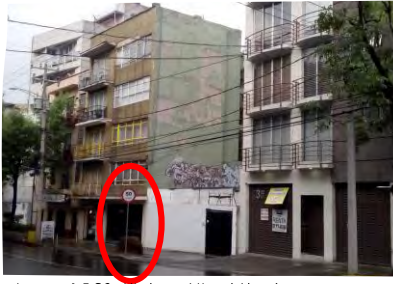
Imagen 1.3.20: Viaducto. Miguel Alemán
