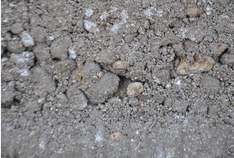
Fig. 65. Detalle de los distintos tipos de granulometría de los componentes, en una tapia recién fabricada. (Fotografías: Acervo del LABPySCT)
