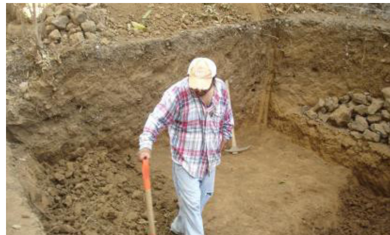
Figs. 90 y 91. Capas de tierra. En la imagen 90 puede apreciarse la capa superficial de tierra negra o humus, no apta para construir. En la imagen 91 se muestra la capa arcillosa, materia prima ideal para la construcción con tierra. (Fotografías: Ángeles Vizcarra).
