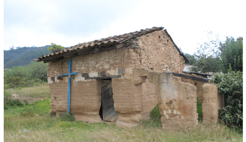
Fig. 40. Arquitectura doméstica rural en el estado de Puebla, hecha con tapias de tierra. (Fotografías: acervo del LABPySCT)
