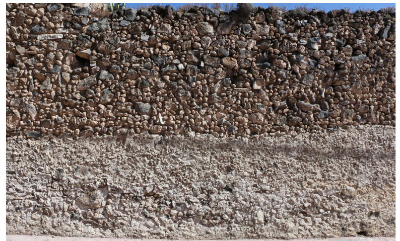
Figs. 24 y 25 Detalle de los muros donde se aprecian los distintos tipos de piedra empleados en los muros, y el recubrimiento de piedra pómez y/o tepalcates.
