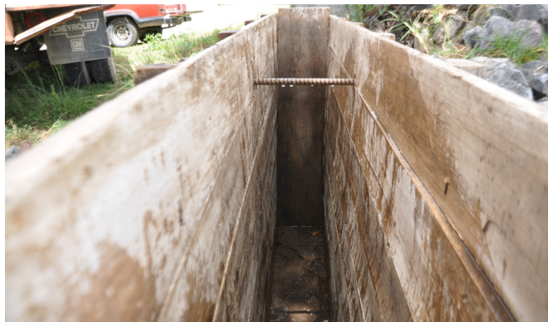
Fig. 73. Tirantes metálicos interiores para evitar deformaciones del tapial. (Fotografías: acervo del LABPySCT)
