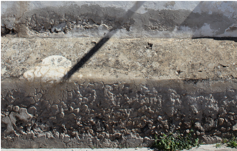
Figs. 26 y 27. Edificios en Tepeyahualco que aún conservan el recubrimiento de cal (fotografías: acervo del LABPySCT)
