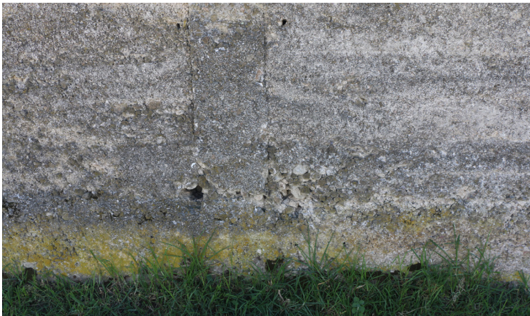
Figs.87 y 88. En estas imágenes se muestra el correcto cuatrapeo o contrapeo de las tapias en un muro intermedio, intersectando las piezas también contrapeadas. (Fotografías: acervo del LABPySCT)
