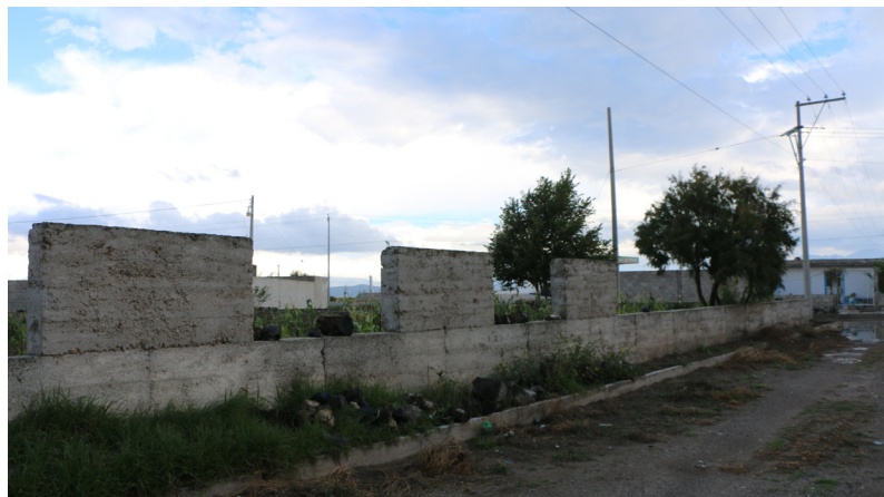
Fig. 79. Alternancia en la construcción de los bloques de tapia, para permitir el proceso de secado. (Fotografía: acervo del LABPySCT)
