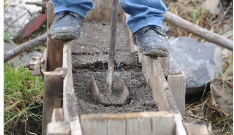
Fig.77. Proceso constructivo: apisonado (Fotografías: acervo del LABPySCT)
