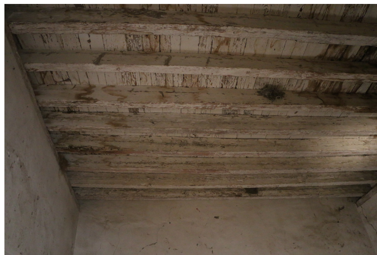
Fig. 41. Sistema de vigas de madera que sostiene la cubierta. (Fotografía: acervo del LABPySCT)
