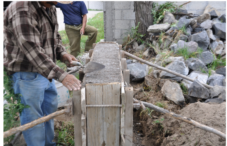
Fig.78. Proceso constructivo: terminado. (Fotografías: acervo del LABPySCT)
