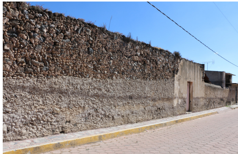
Figs. 22 y 23. Construcciones en Tepeyahualco, donde se aprecia la construcción con piedra, al quedar los muros sin el recubrimiento de cal.
