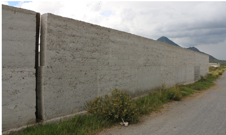
Figs. 83 y 84. En estas imágenes puede observarse el correcto contrapeo de las tapias, con piezas alternadas a la mitad, con el fin de evitar que la junta constructiva sea continua, para dar mayor rigidez al muro, como en cualquier tipo de mampostería. (Fotografías: acervo del LABPySCT)
