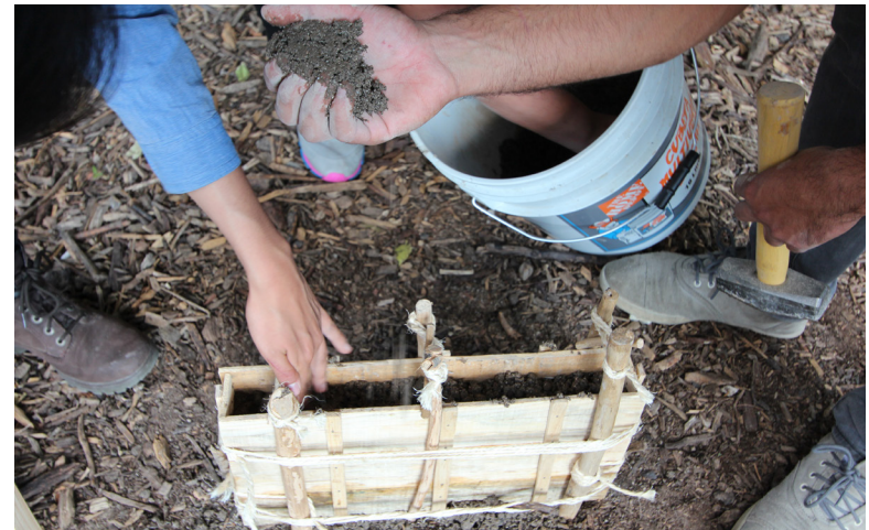
Figs. 102 y 103 Reproducción de la tapia en laboratorio escala 1:5. Armado del encofrado, preparación de la mezcla y apisonado. (Fotografías: acervo del LABPySCT)
