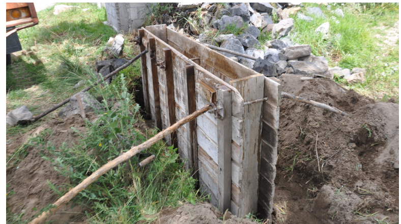
Fig. 72. Encofrado de madera, se aprecian los puntales de madera para evitar el movimiento del cajón al momento de apisonar (Fotografía: acervo del LABPySCT)
