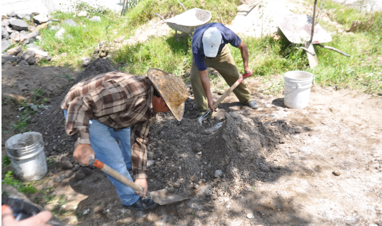
Fig. 75. Materiales de la tapia y mezclados en seco. (Fotografías: acervo del LABPySCT)
