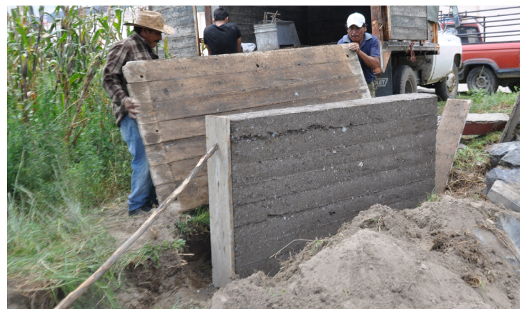
Fig. 81. Proceso constructivo: descimbrado y tapia terminada (Fotografías: acervo del LABPySCT)
