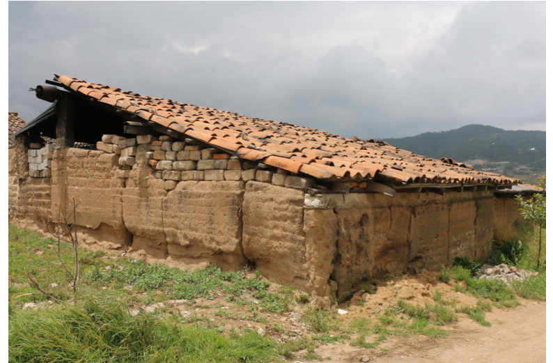
Fig. 39. Arquitectura doméstica rural en el estado de Puebla, hecha con tapias de tierra. (Fotografías: acervo del LABPySCT)
