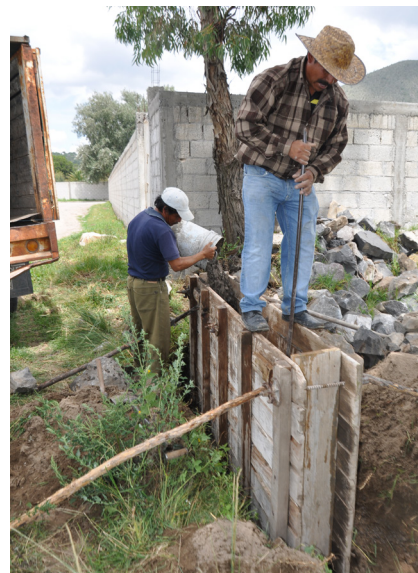
Fig. 80. Proceso constructivo: vaciado de la mezcla y apisonado (Fotografías: acervo del LABPySCT)
