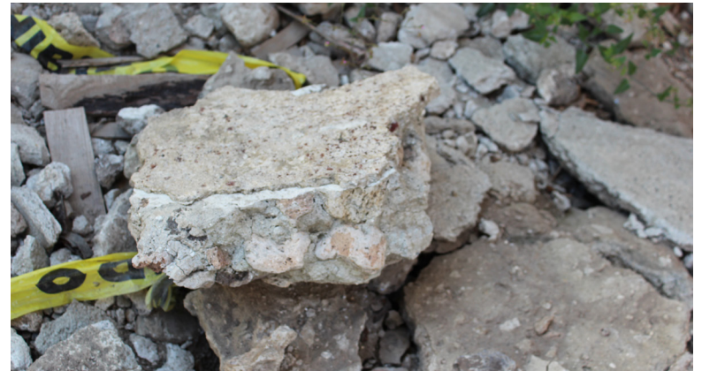
Figs. 44 y 45. En la imagen 44, puede apreciarse cómo el terrado de la cubierta se sostiene aún sin el apoyo de las vigas y el tejamanil, lo que demuestra la resistencia de la combinación de materiales. En la imagen siguiente, se aprecia el detalle de los materiales en una construcción demolida: piedra pómez y tepojal, con una mezcla de cal y arena. (Fotografías: acervo del LABPySCT).
