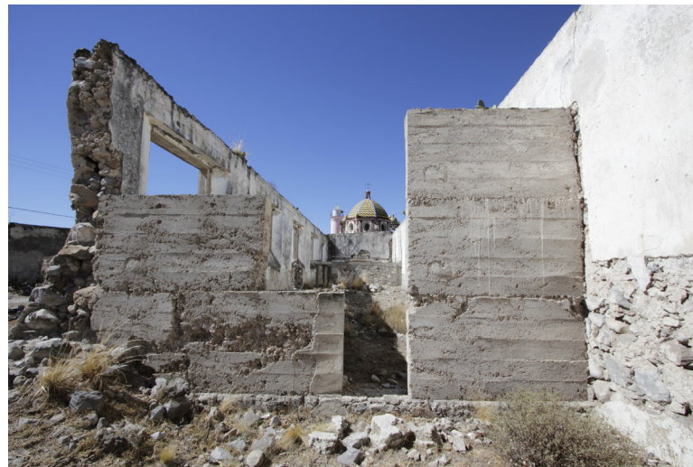
Fig. 48. Tapia de piedra pómez y cal. Hacienda Pizarro, Tepeyahualco. (Fotografía: Acervo del LABPySCT)
