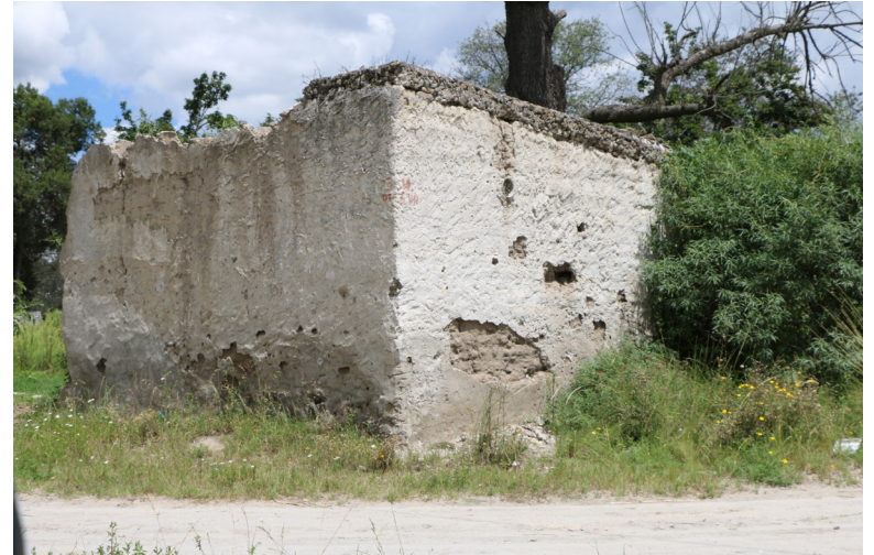
Fig. 34. Restos de Tapia en la comunidad de El Fuerte de la Unión. (Fotografía: acervo del LABPySCT)
