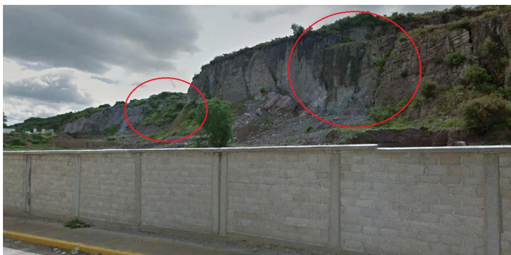
Foto 5. Calle Juan de la Barrera, Colonia Sta. María Cuauhteppec. En el círculo rojo del lado derecho, fractura en talud. Círculo rojo lado izquierdo, flujo de suelo cohesivo.
