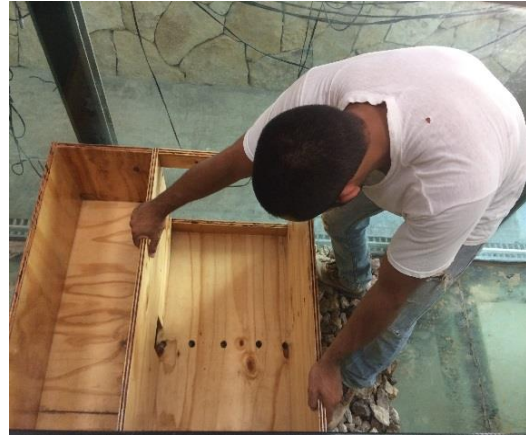
Figura 26. Colocación del dique encima a banqueta
