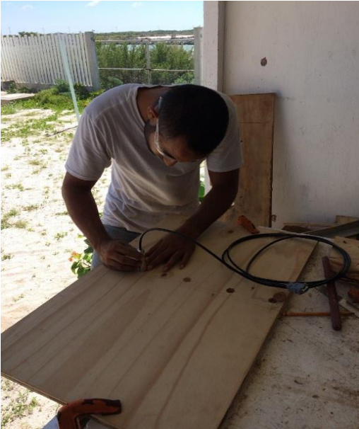
Figura 22. Construcción del cajón del dique
