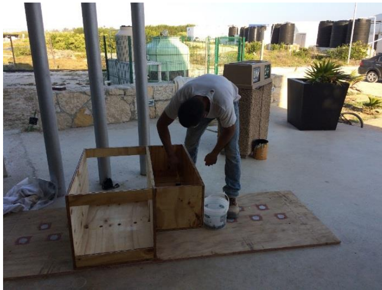
Figura 24. Sellado de la madera con resina
