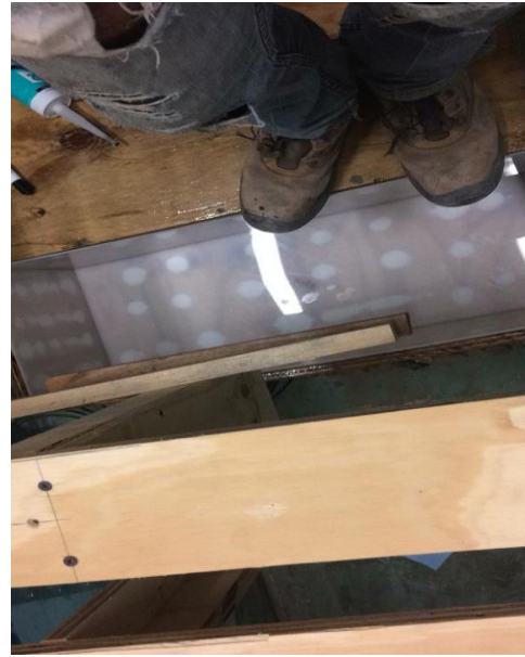
Figura 23. Construcción y forrado del vertedero con láminas de acrílico
