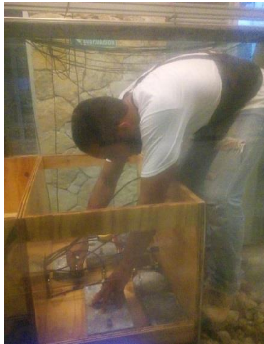
Figura 27. Colocación de los contrapesos
