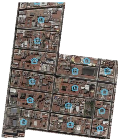
Figura 4.6 Viviendas particulares I.
