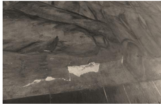
Figura 1.23 Deterioro de los murales en el Mercado Abelardo Rodríguez. Fotografía tomada por la autora, 2015.
