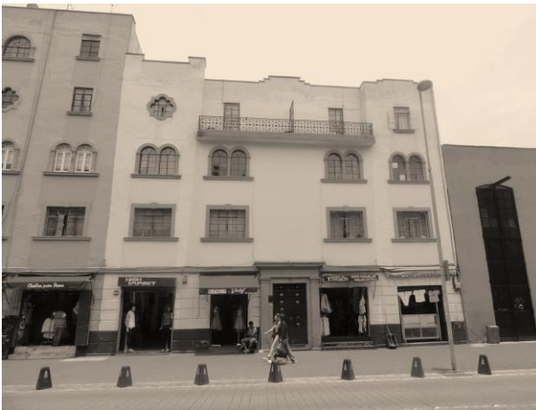
Figura 1.29 República de Venezuela. Edificio de vivienda. Fotografía tomada por la autora, 2016,
