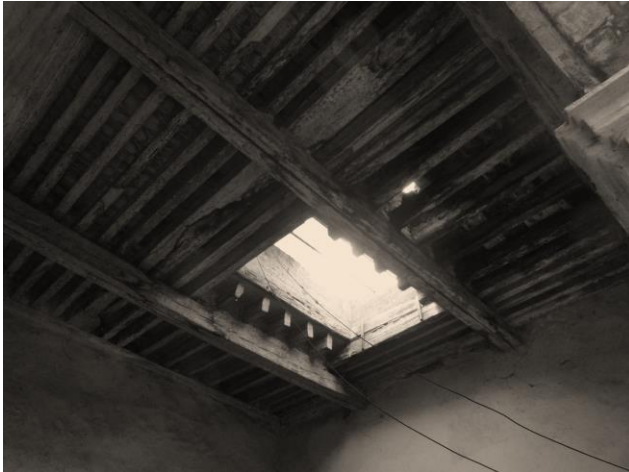
Figura 1.27 Entablillado sin mantenimiento. Fotografía tomada por la autora, 2015.
