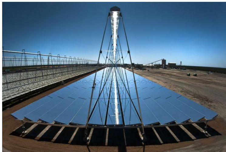
Figura 17. Planta termosolar con tecnología lineal de Fresnel en India. Fuente: Revista Eólica y del Vehículo Eléctrico (reve)
