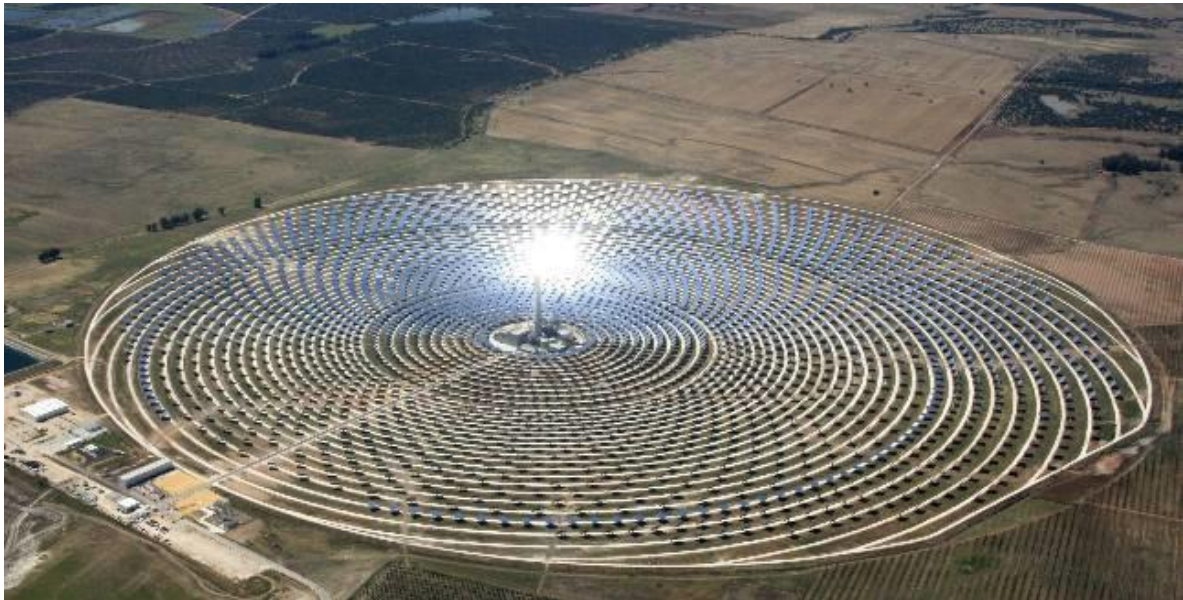
Figura 18. Planta de torre termosolar, Gemasolar, España.
