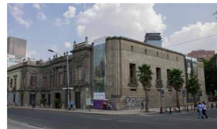
2. Vista de la fachada norte, se aprecian las 3 etapas. Imagen 65. [Fotografía de Rafael Ramírez]. (CDMX.2017)
