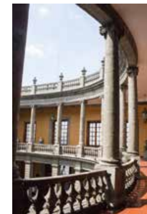
16. El patio visto desde la planta alta. Imagen 116. [Fotografía de Rafael Ramírez]. (CDMX.2017)
