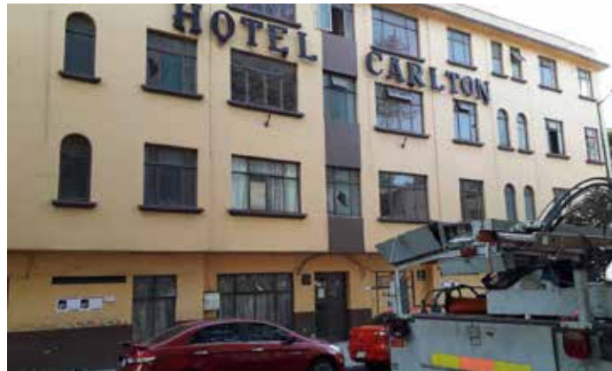
11. Estado actual de la fachada norte del Hotel Carlton. Imagen 74. [Fotografía de Mariana Brito]. (CDMX.2019)
