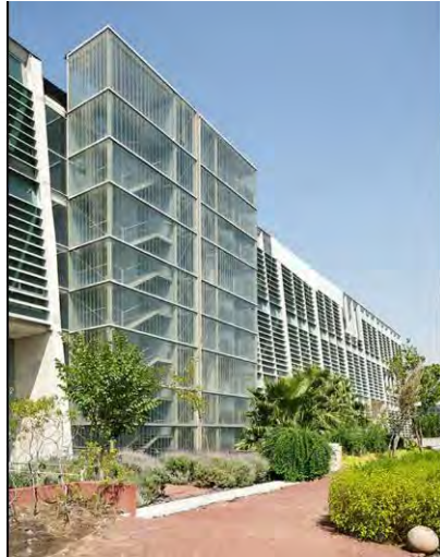
Fachada Oriente con celosías para protección de ventanas y control de iluminación en el interior
