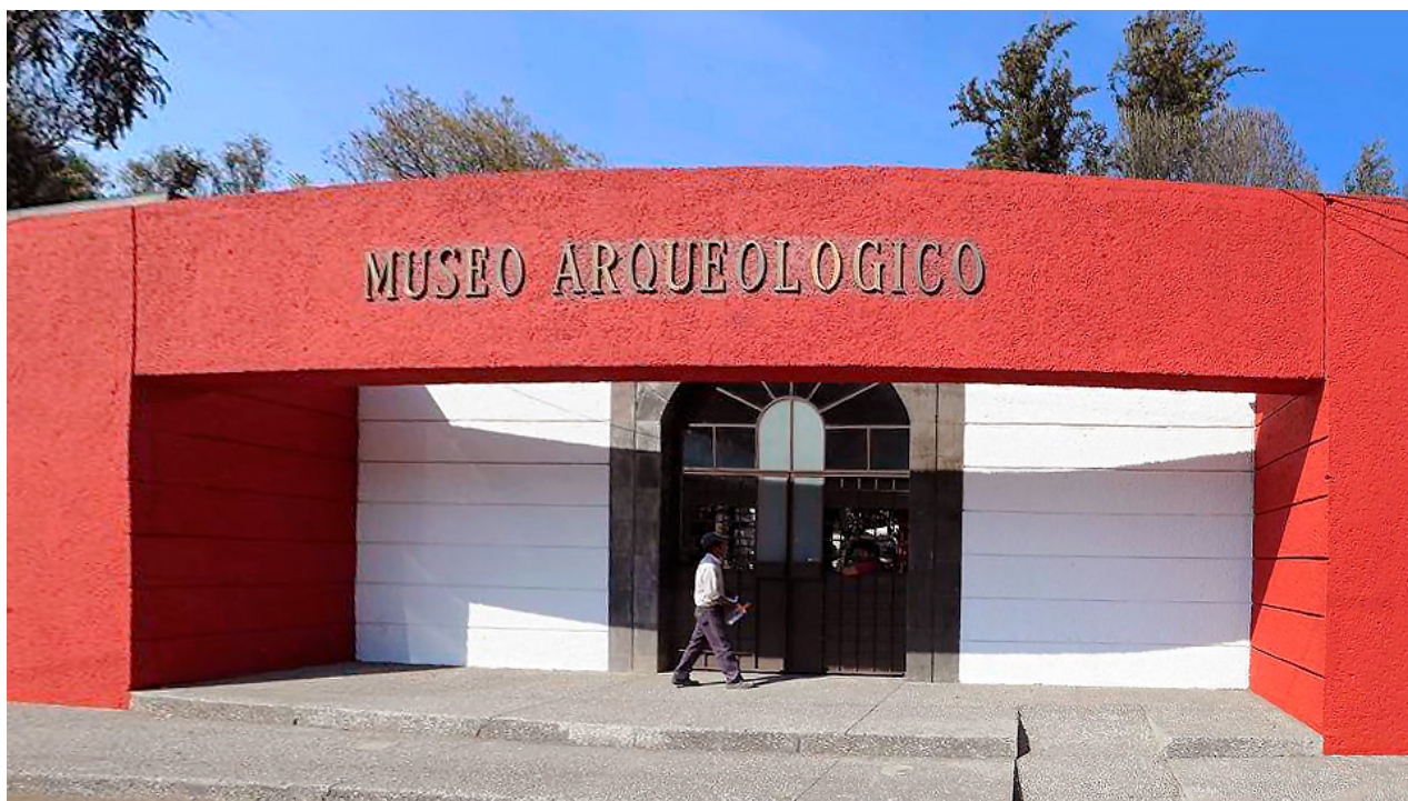
Imagen | Acceso del museo recientemente intervenido debido a daños por el terremoto del 19 de sep. de 2017 en la Ciudad de México.
