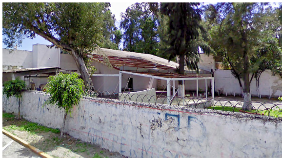
Fotografía | Oeste del predio, baños y cubierta adicionales.
