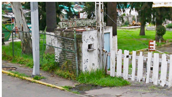
Fotografía | Caseta de vigilancia con baño en abandono.
