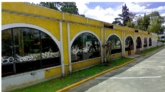
Fotografía | Fachada noreste actual del restaurante.
