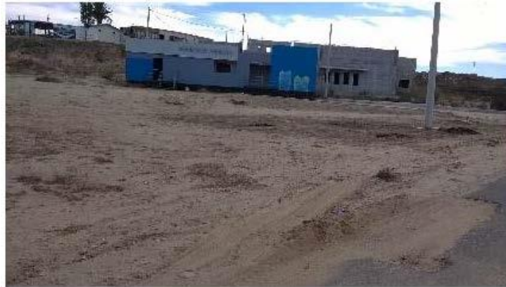
Fotografía 3.1. Estación de policía abandonada.
