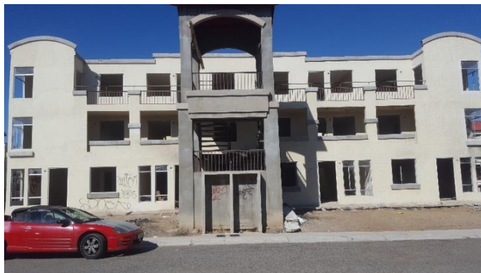
Fotografía 4.16. Edificio con doce condominios abandonados Prototipo dodecadúplex.
