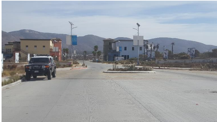
Fotografía 4.12. Edificios de área comercial abandonadas por el constructor/vendedor.
