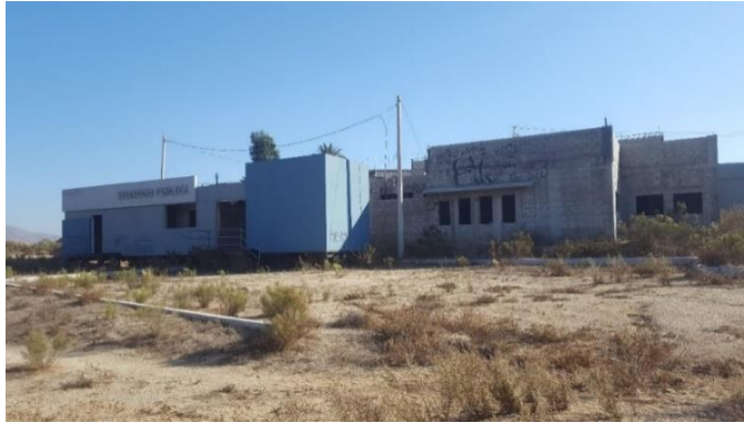
Fotografía 4.4. Estación de policía abandonada.
