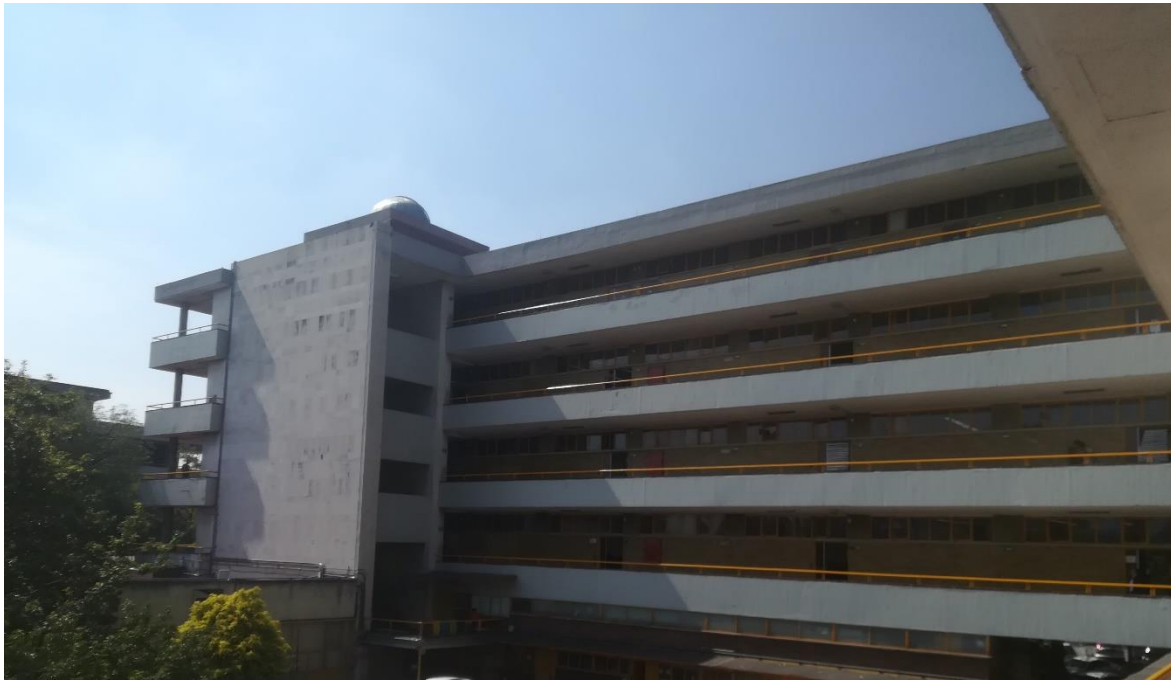
Figura 4.4 Vista actual del edificio B FI, UNAM
