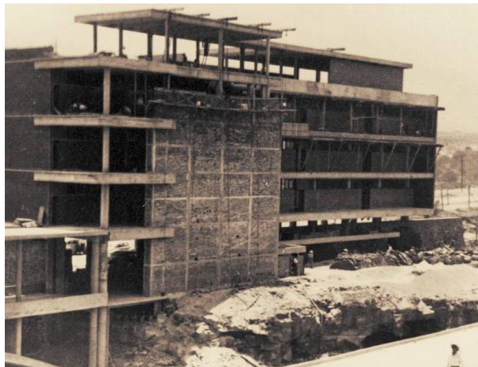
Figura 4.1. Construcción Ed. B FI, UNAM, (FI UNAM, 2019)
