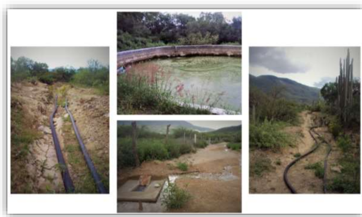
Imagen 35. Tanque de captación de agua de lluvia de Tilapa (registrado en CONAGUA), cisternas y mangueras sobre viejos canales de barro para irrigación de campos agrícolas aledaños.
