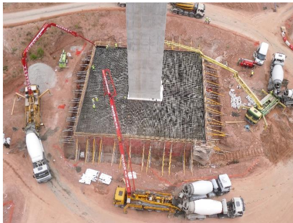
Figura 4.2. Vista aérea del colado de una zapata de cimentación. (Barba, 2013)
