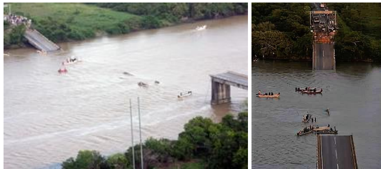
Figura 1.8. Colapso del Puente Tonalá I, frontera Tabasco-Veracruz. El Universal (2009a y 2009b)
