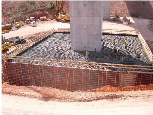
Figura 4.1. Armado del acero de refuerzo y colocación de cimbra en zapata de cimentación. (Barba, 2013)
