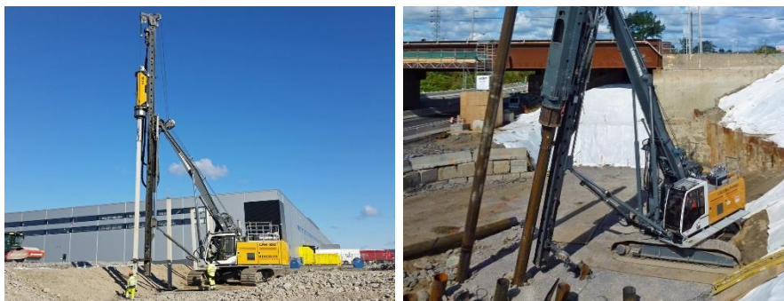
Figura 4.4. Hincados vertical e inclinado de pilotes prefabricados, por percusión. (Liebherr, 2018)
