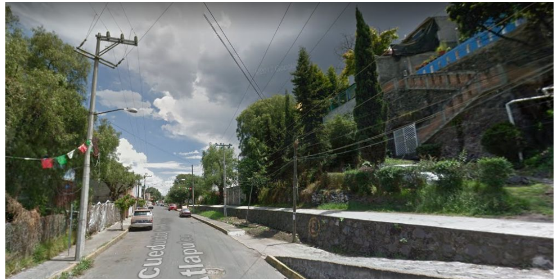
3. Avenida Acueducto San Gregorio. Instalaciones eléctricas a la vista. Vegetación presente. Viviendas de cemento. Captura de pantalla 9.
