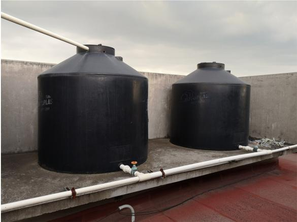
Imagen 22. Tanques en cubierta de 2500 lts cada uno. Fuente fotográfica: Elaboración propia.
