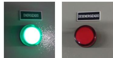
Imagen 40. Indicadores de control para energizado y des-energizado de los equipos en el tablero eléctrico.
