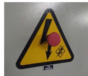
Imagen 41. Sistema de emergencia en el tablero eléctrico de los equipos.
