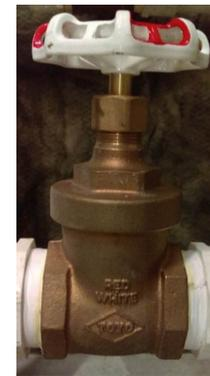
Imagen 37. Válvula tipo cortina, permite regular el paso del agua.
