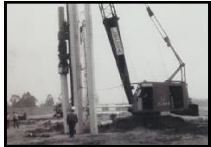
Fig. 58. Cimentación a base de Pilotes.
