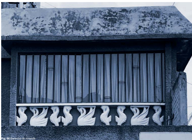
Fig. 68 Barandil de vivienda.
