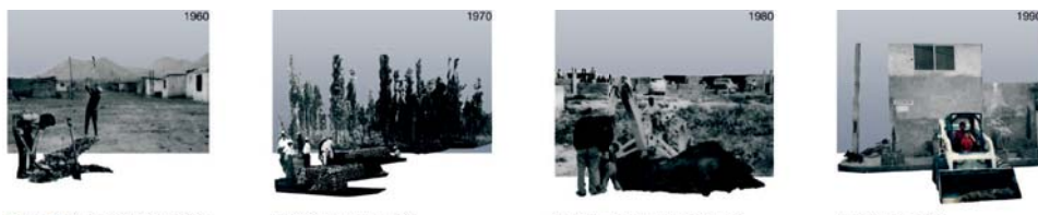
1960 José Rocó. Miembro fundador/ Ex ejidatario 1970 La colonia era una zona agrícola 1980 Las personas construyeron su patrimonio 1990 Le enseñaron a sus hijos
