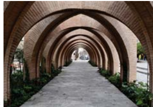
Arq: Estudio mwx Estatus: en construcción
