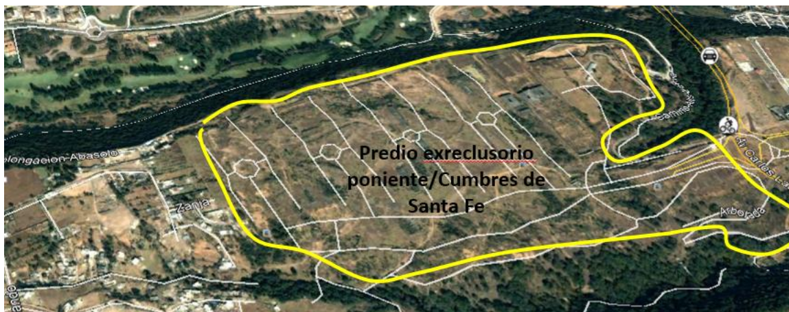
Figura 16. Imagen de satélite del predio Exreclusorio poniente, 2003
