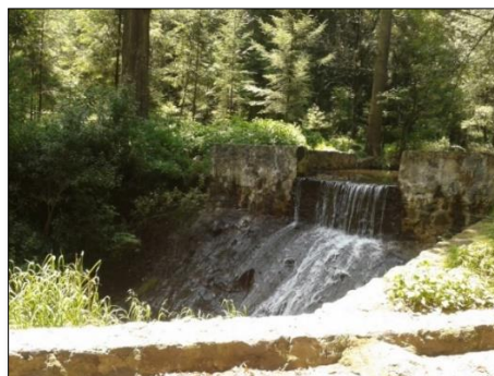
Imagen 6. Arroyo Santo Desierto
