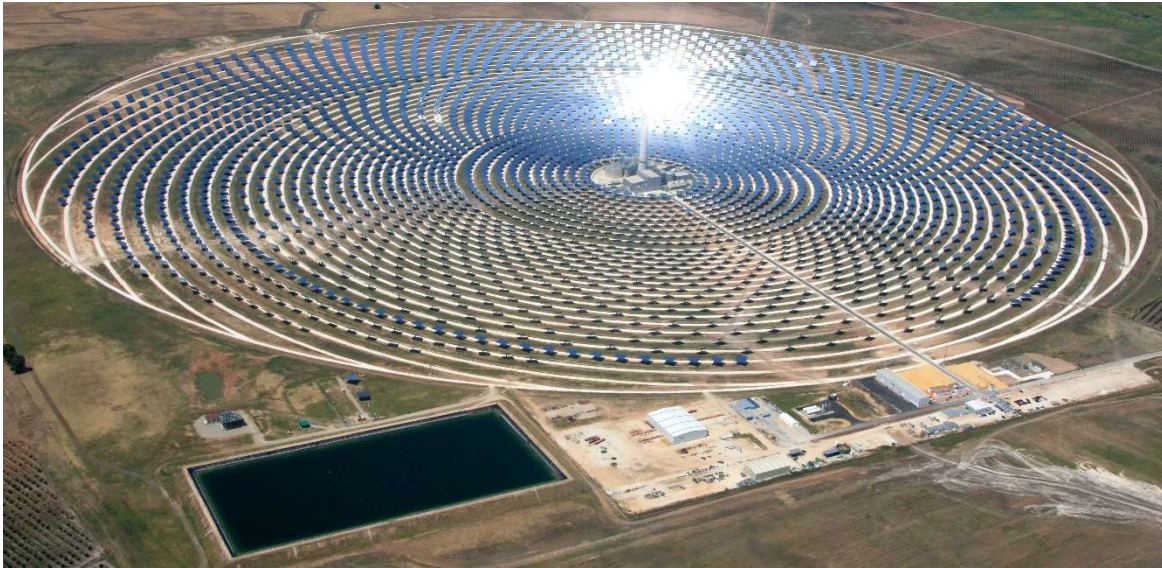
Ilustración 3.12 Planta solar térmica Gemasolar, Sevilla, España
