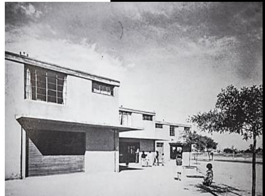
Fotografía de fachadas de vivienda tipo 2, casa mínima obrera, Juan Legarreta, 1933. Fuente: Internet
