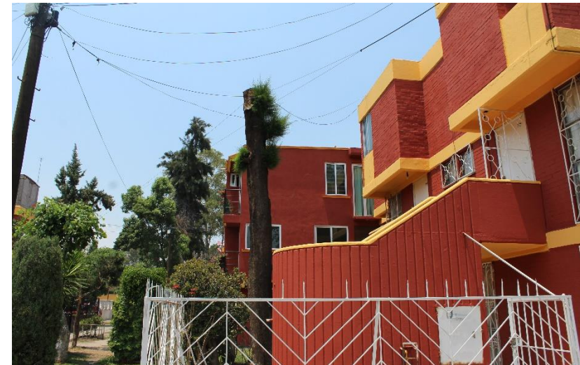
Fotografías de fachadas de vivienda multifamiliar, U.H. CTM Culhuacán Piloto. Fuente: Brigadas de Laboratorio de Vivienda 2018
