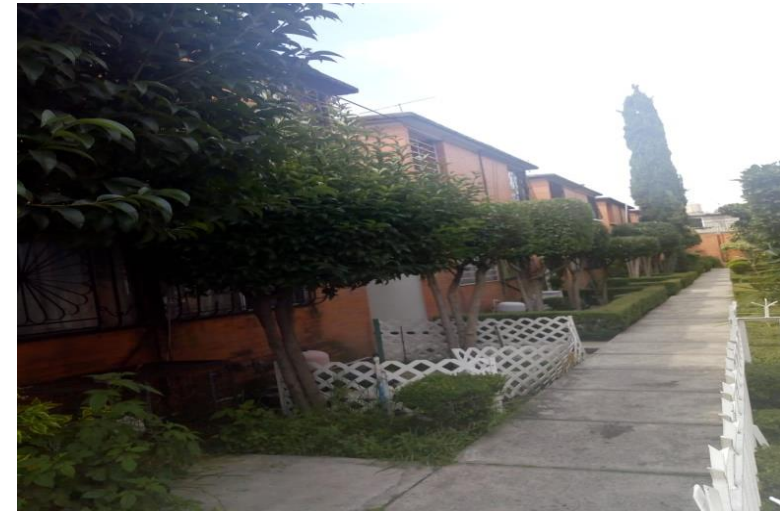
Fotografía de fachada de vivienda unifamiliar, U.H. Residencial del Valle. Fuente: Brigadas de Laboratorio de Vivienda 2018
