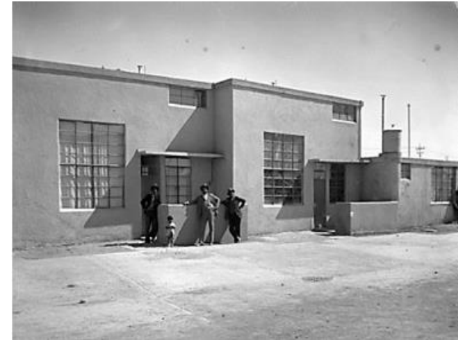
Fotografía de fachadas de vivienda tipo 1, casa mínima obrera, Juan Legarreta, 1933. Fuente: Internet
