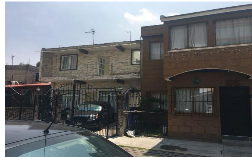
Fotografía de fachada de vivienda unifamiliar, U.H. CTM Culhuacán X.
